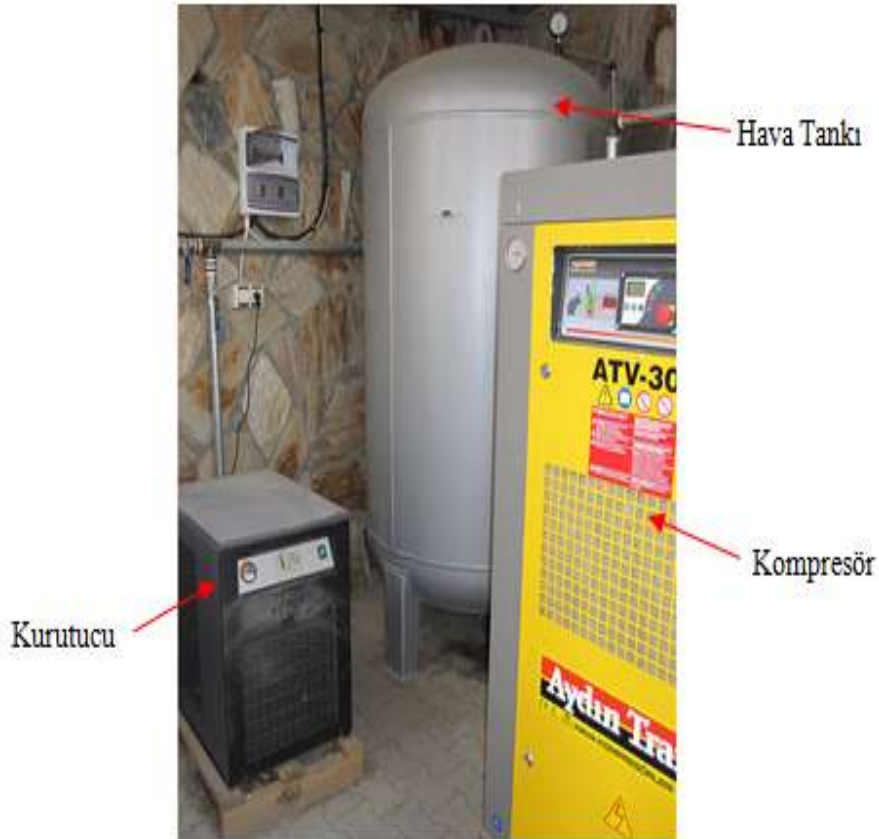
Şekil 3.1. Basınçlı hava tesisatı elemanları
