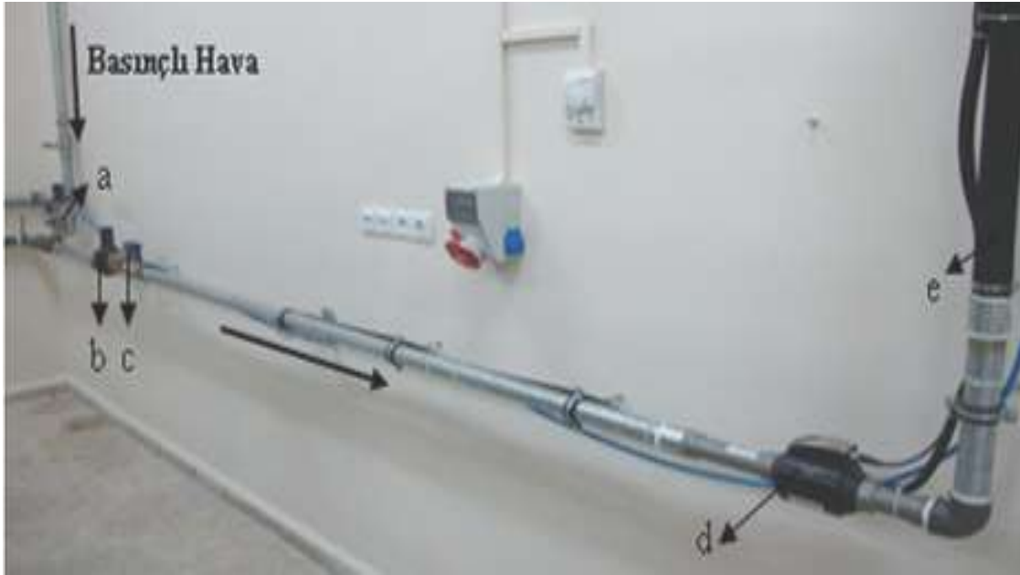
Şekil 3.3. a) Hava şartlandırıcı b) regülâtör (1 ½”) c) selenoid valf d) DN 40 Debimetre e) hava hortumu
