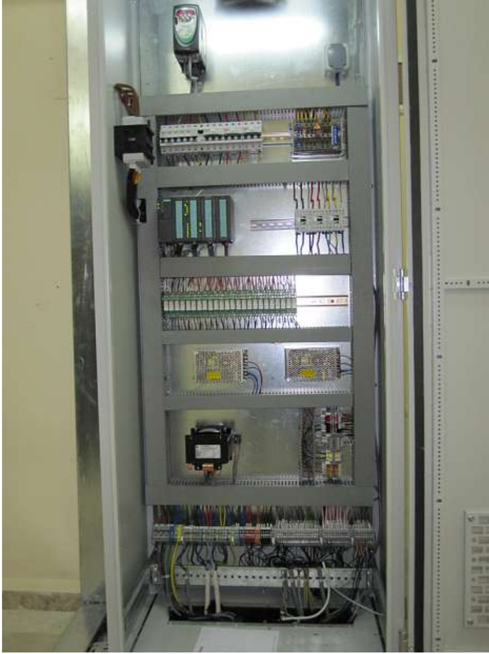
Şekil 3.13. PLC ve otomasyon panosu
