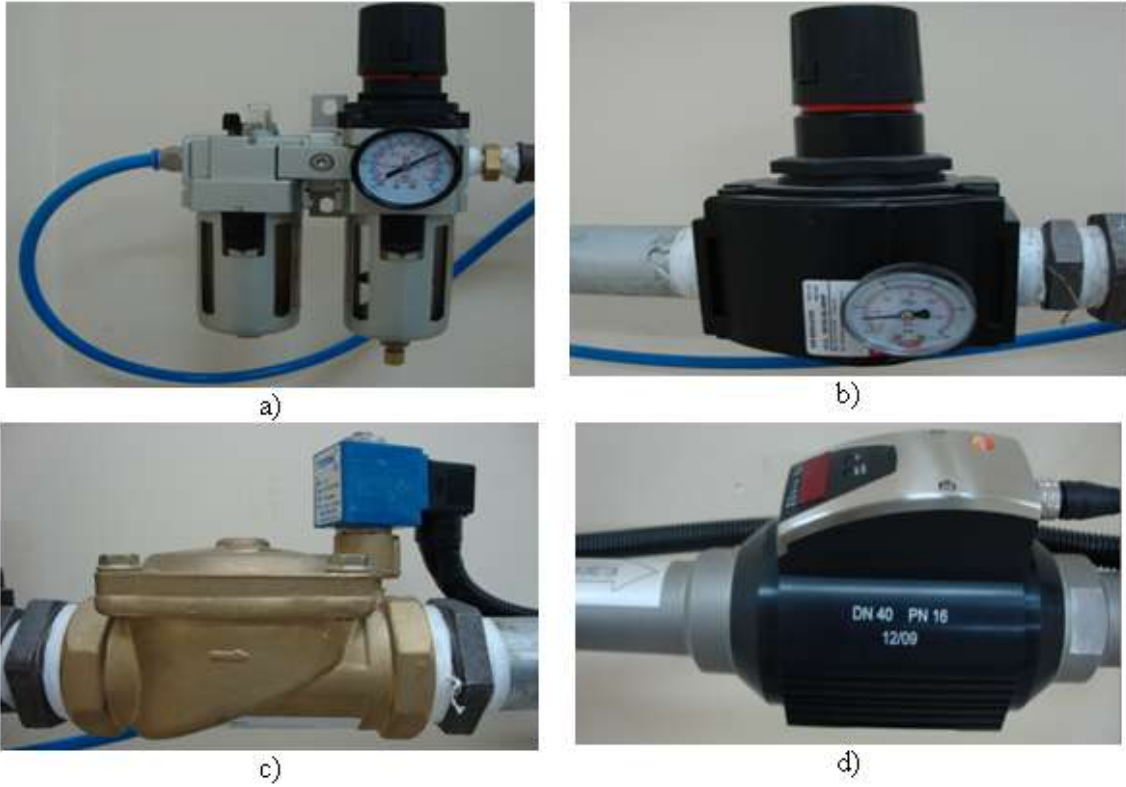
Şekil 3.2. a) Şartlandırıcı, b) regülatör, c) selenoid valf, d) debimetre
