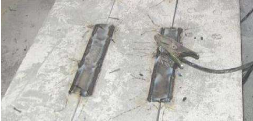
Şekil 3.54. TİP4 Modeli bağlantı detayı (Çelik bağlantı levha takviyesi)
