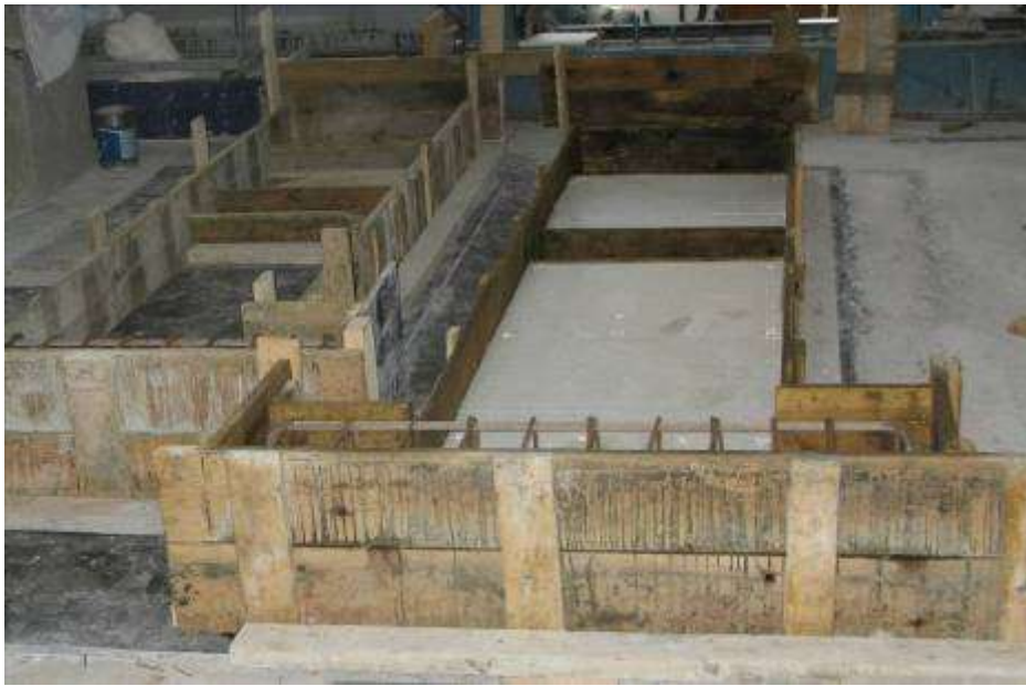
Şekil 3.41. Perde kalıplarının hazırlanması
