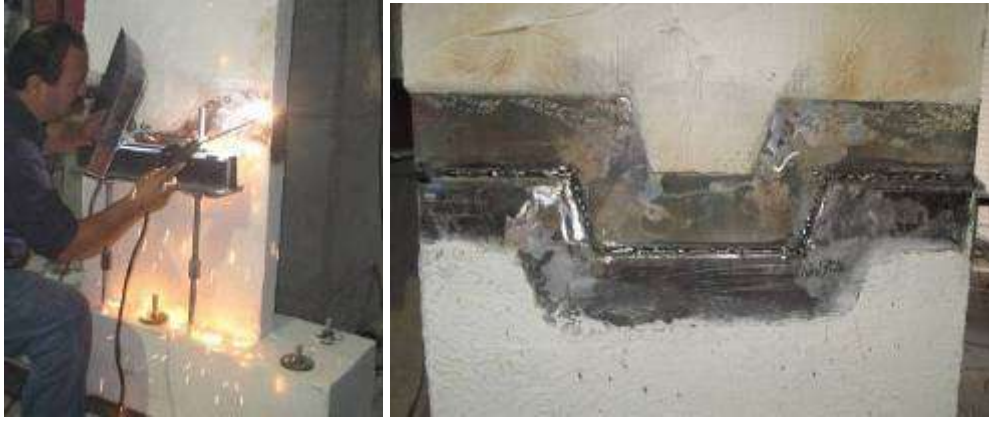
Şekil 3.62. TİP1 ve TİP2 Perde panellerinin birleşim bölgesinin kaynaklı teşkili
