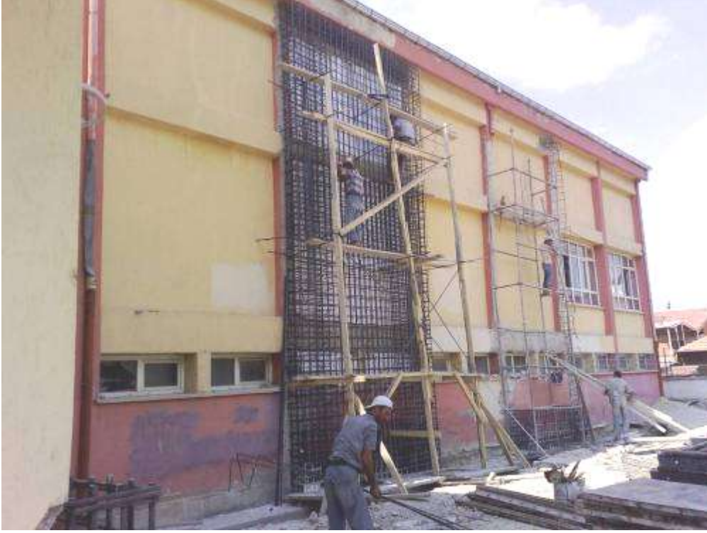
Şekil 1.2. Bir okul binasında yerinde dökme dış perde duvarla güçlendirilme uygulaması
