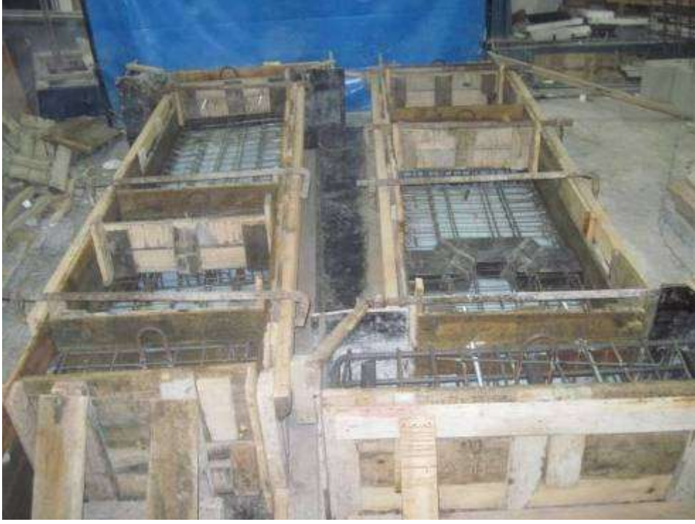
Şekil 3.48. Referans Model ve TİP1 Modeli beton dökümü öncesi
