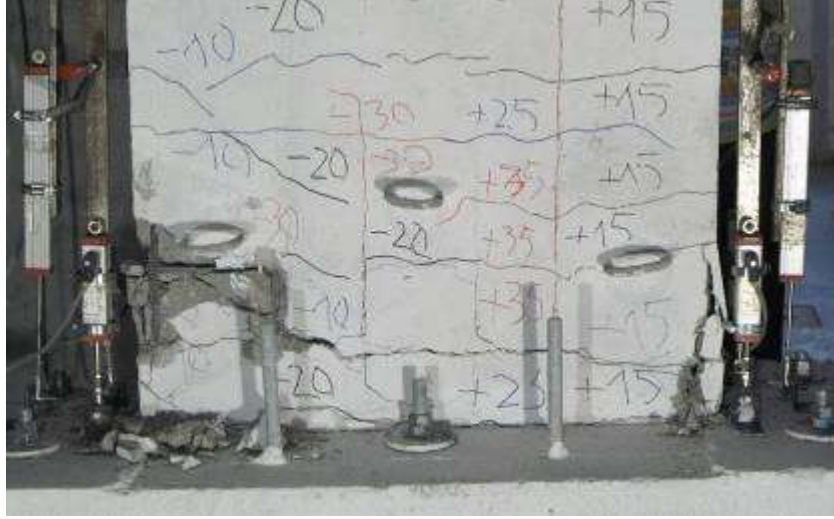
Şekil 4.43. Perde tabanının her iki köşesindeki boyuna donatı burkulması.
