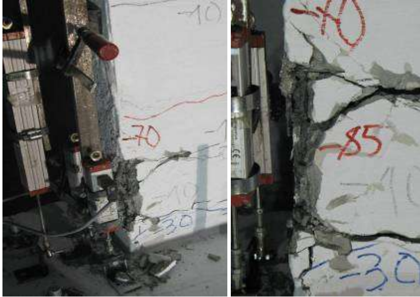
Şekil 4.14. Perde betonunda blok halinde dökülmeler, kopmuş boyuna donatıları
