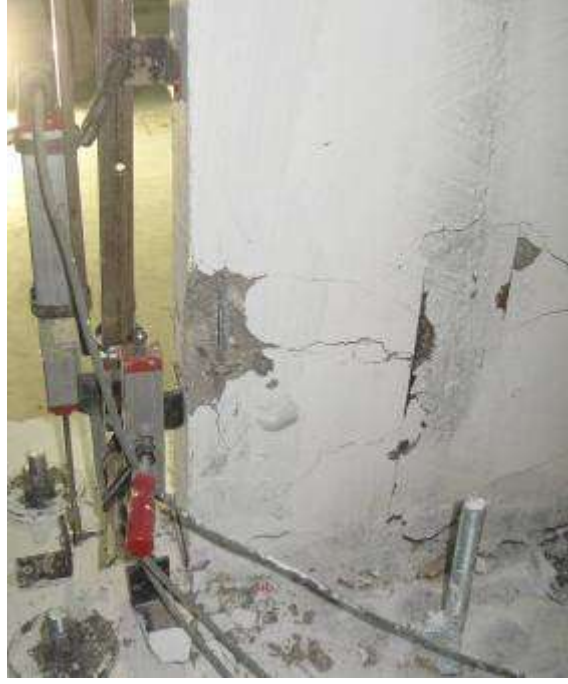
Şekil 4.35. -90 mm tepe deplasmanında boyuna donatıda burkulma davranışı.
