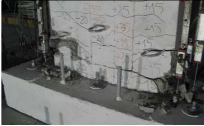
Şekil 4.44. Perde tabanının her iki köşesindeki kopan boyuna donatı
