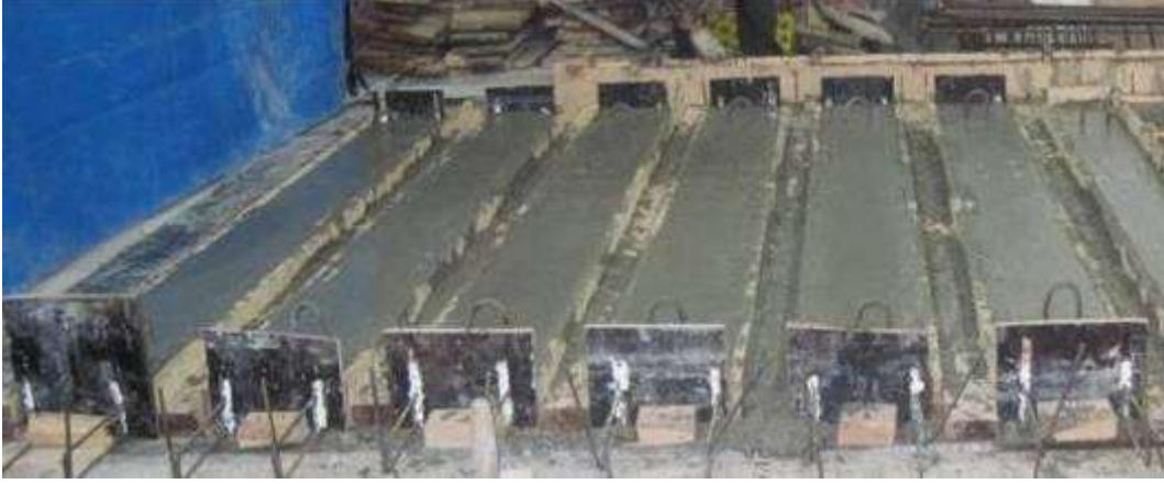
Şekil 3.53. TİP4 ve TİP5 Modelleri beton döküm sonrası
