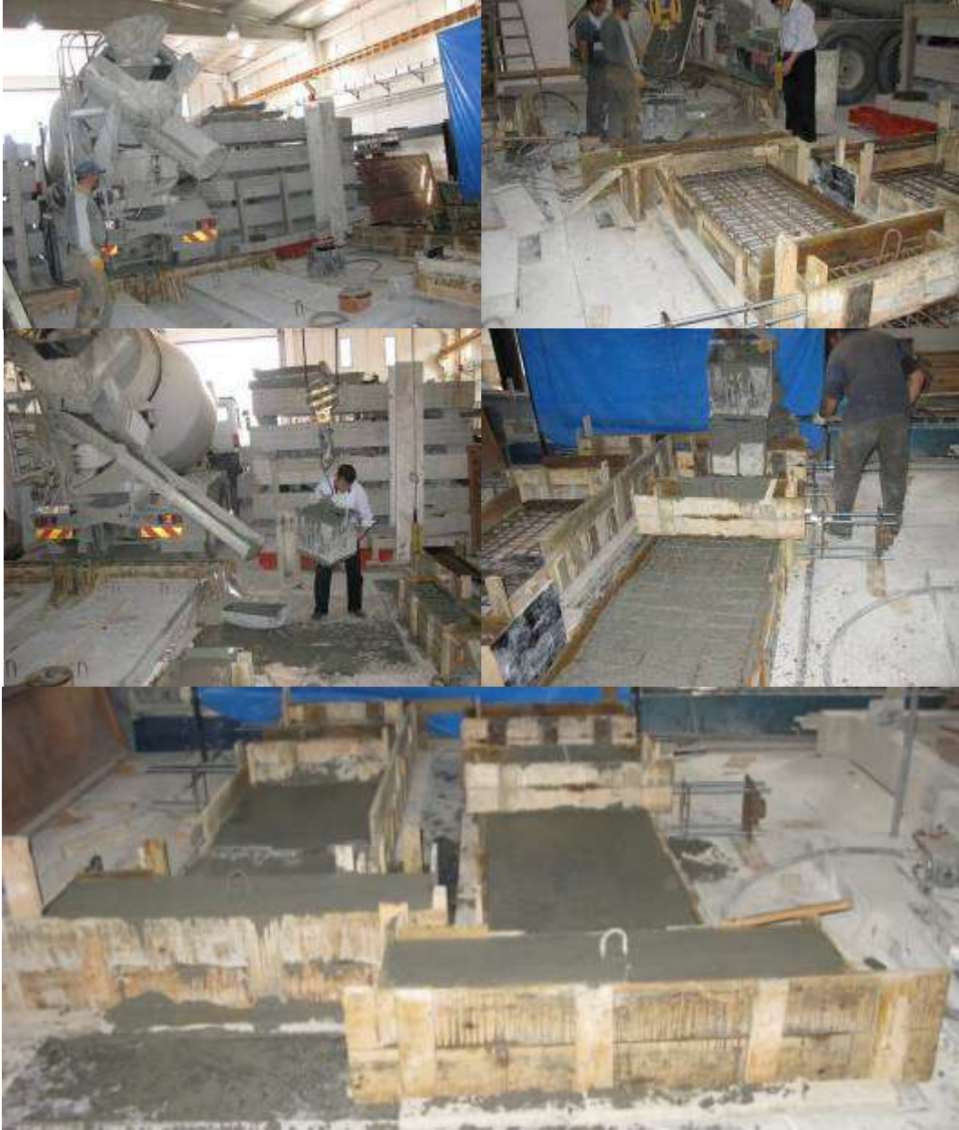
Şekil 3.44. Laboratuvar ortamında beton dökümü
