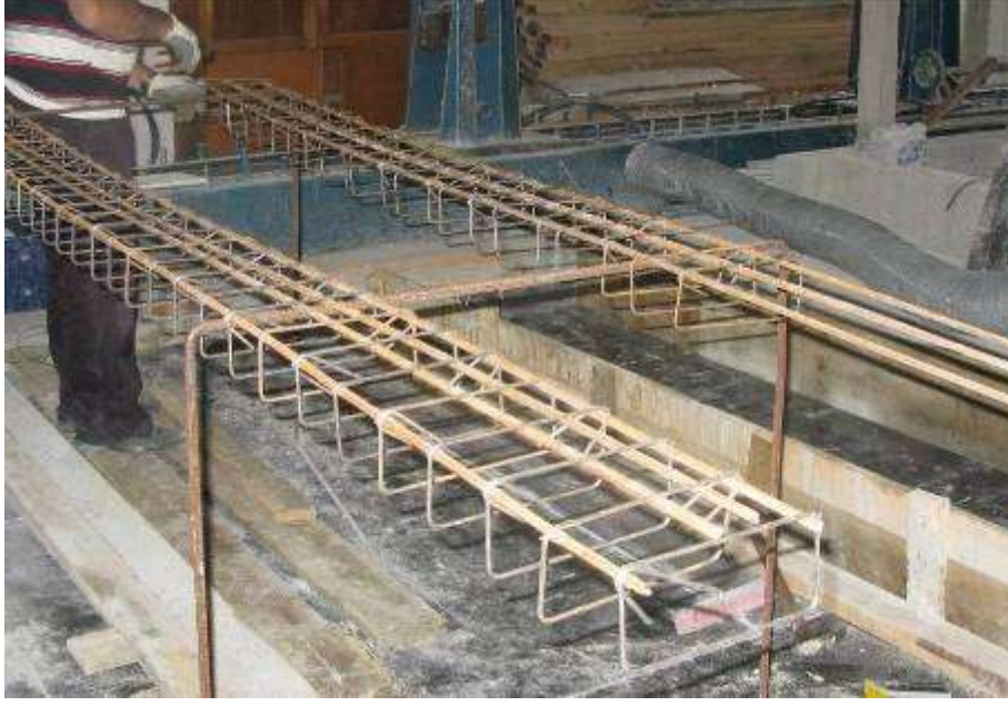
Şekil 3.42. Perde donatılarının hazırlanması
