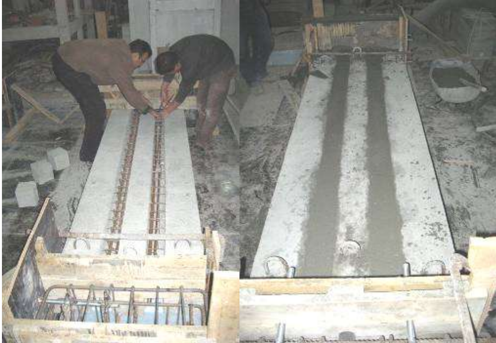
Şekil 3.57. TİP6 Modeli bağlantı yeri donatı detayı ve beton döküm sonrası
