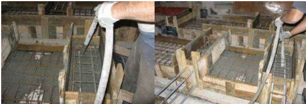
Şekil 3.45. Vibrasyon uygulaması
