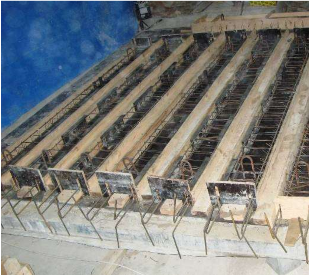
Şekil 3.52. TİP4, TİP5 Modelleri imalat detayı
