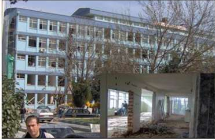
Şekil 2.3. Denizli Devlet Hastanesinde kullanımı aksatan güçlendirme uygulaması
