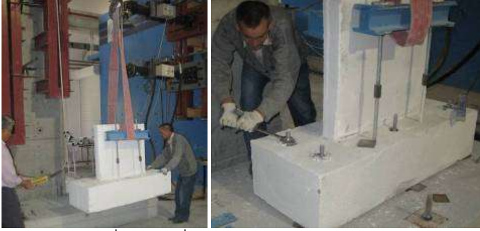
Şekil 3.58. TİP3-1 ve TİP3-2 Modeli alt panelinin temele montajı
