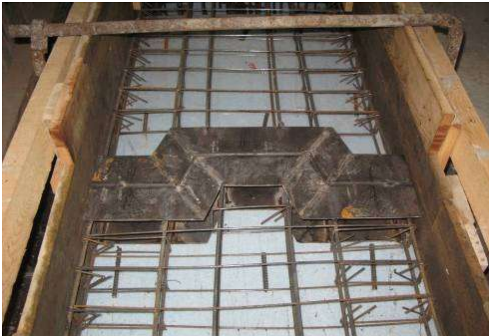
Şekil 3.47. TİP1 ve TİP2 Modellerinde uygulanan yatay bağlantı detayı
