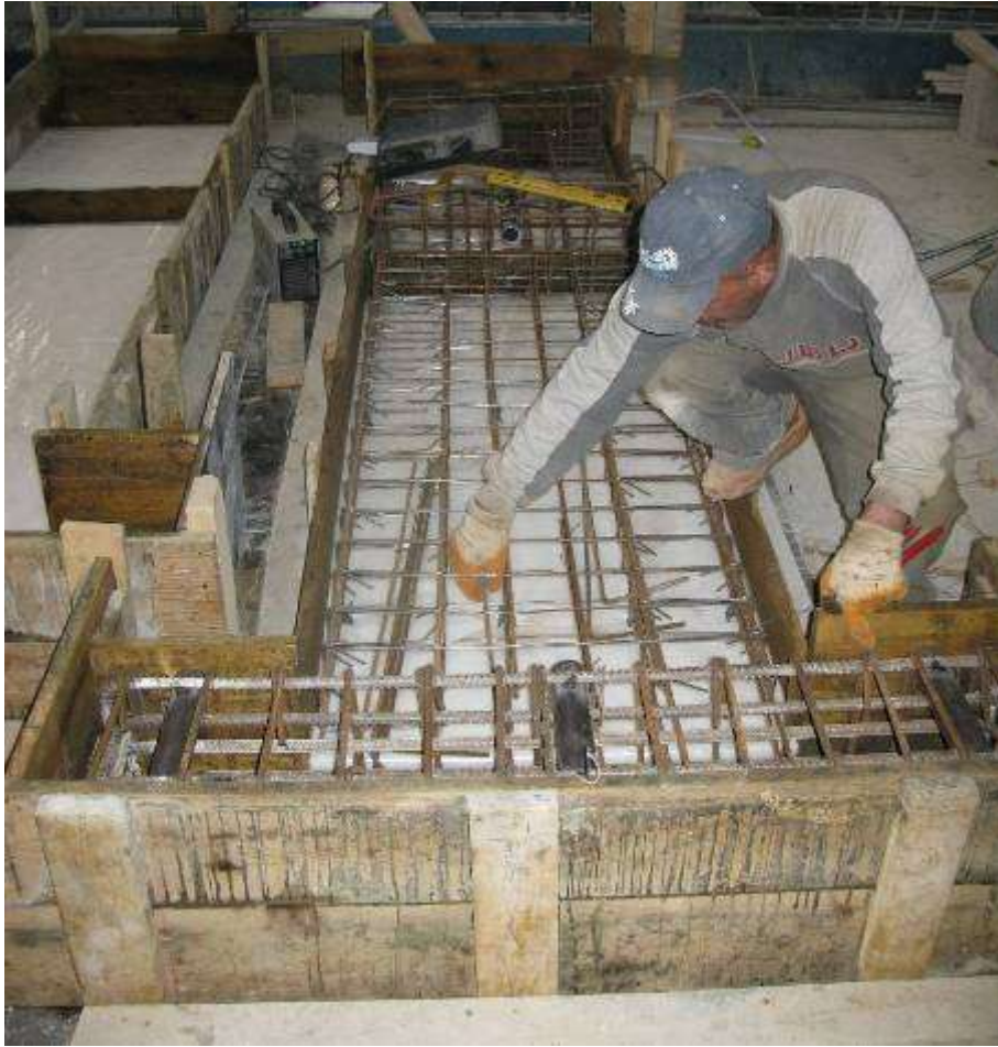
Şekil 3.43. Donatıların kalıba yerleştirilmesi
