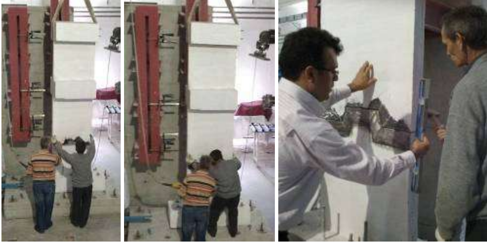
Şekil 3.61. TİP1 ve TİP2 Modeli üst paneli yerleştirilmesi
