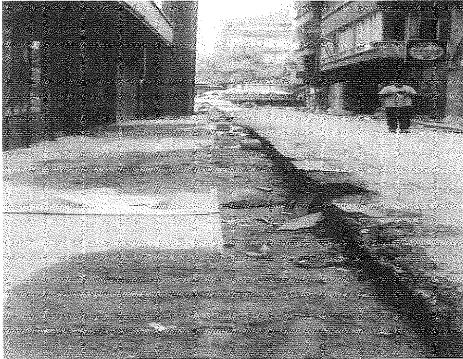
Şekil 2. Adapazarı'nda Çark Caddesi civarında bir sokak boyunca zemin yüzeyine fıskırmış silt ve ince kum öbekleri (Sucuoğlu vd 2000)
