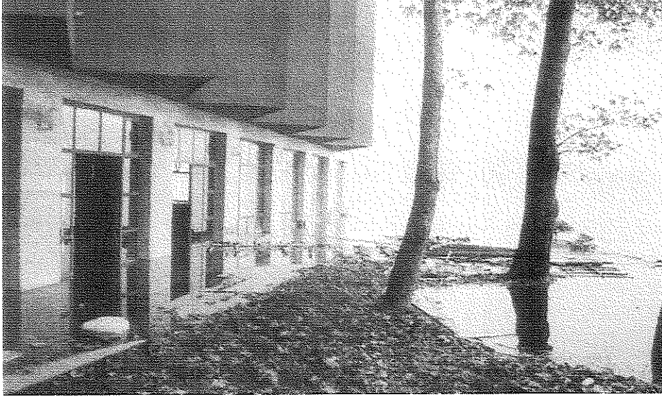
Şekil 5. 1999 Kocaeli depreminde Sapanca Gölünün Adapazarı'na yaklaşık 5km mesafede yer alan doğu kıyısında sivilaşmaya bağlı olduğu düşünülen oturmalar ve denize doğru yanıl yayılımlar sonucunda sahil şeridi kısmen gölün suları altında kalmıştır (Sucuoğlu vd 2000)
