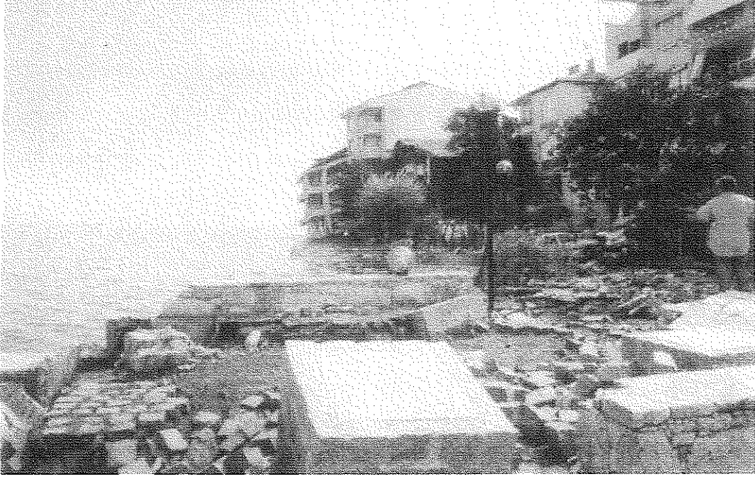
Şekil 8. 1999 Marmara depremi sonrası Değirmendere sahilinin görünüşü. Kıyıya dolgu yapılarak kazanılmış olan alanlar 50m'ye yaklaşan yanıl yayılımlar ile denize kaybedilmiştir (Sucuođlu vd 2000)
