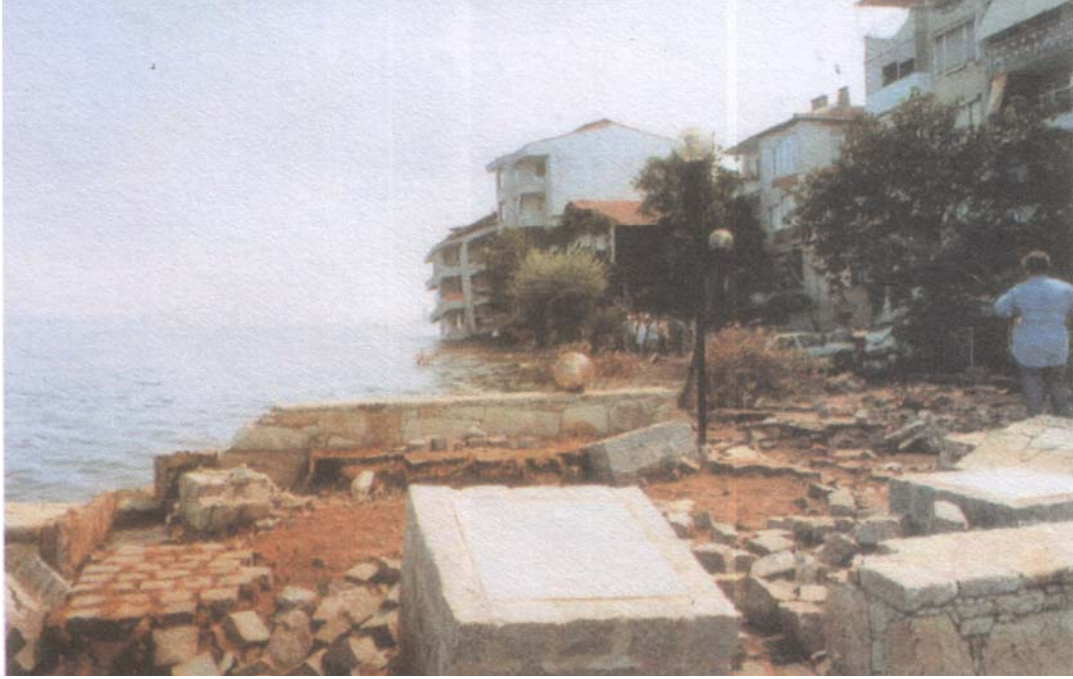
Şekil 8. 1999 Marmara depremi sonrası Değirmendere sahilinin görünüşü. Kıyıya dolgu yapılarak kazanılmış olan alanlar 50m'ye yaklaşan yanıl yayılımlar ile denize kaybedilmiştir (Sucuoğlu vd 2000)
