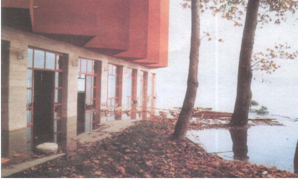
Şekil 5. 1999 Kocaeli depreminde Sapanca Gölünün Adapazarı'na yaklaşık 5km mesafede yer alan doğu kıyısında sıvılaşmaya bağlı olduğu düşünülen oturmalar ve denize doğru yanıl yayılımlar sonucunda sahil şeridi kısmen gölün suları altında kalmıştır (Sucuoğlu vd 2000)
