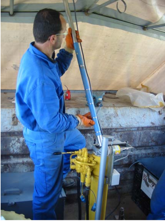
(a) VPT aleti hidrolik itirme ünitesine yerleştirilirken
