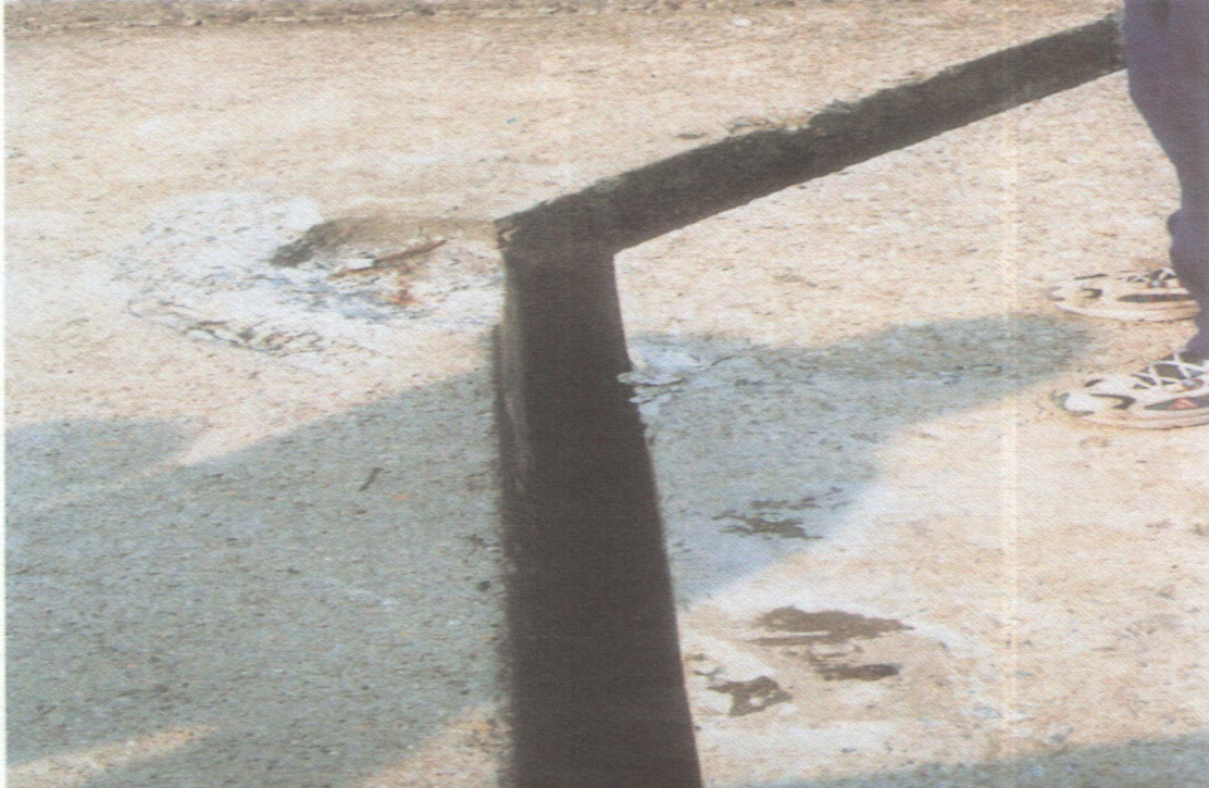
Şekil 7. Petkim rafinerisi iskelesi üzerinde yatay deplasman sonucu meydana gelen yanıl hareket (yaklaşık 15cm) (Sucuođlu vd 2000)
