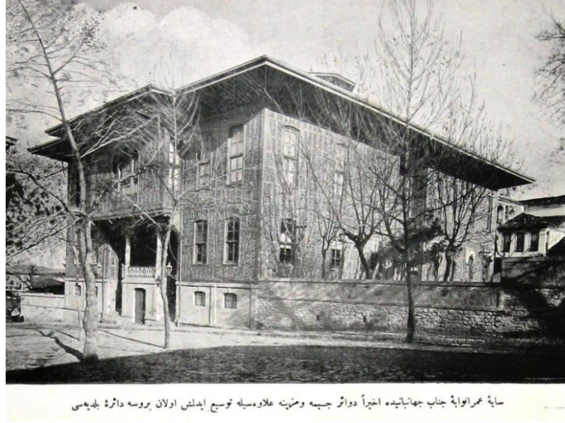
Resim 20: Bursa Belediye Dairesi (HVS 1324: 267)
