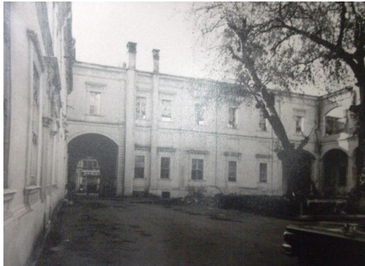
Resim 83: 1970 Yangınından Sonra İzmir Hükümet Konağı'nın İç Avlusu (İzmir Kültür Varlıklarını Koruma Bölge Kurulu Müdürlüğü Arşivi)
