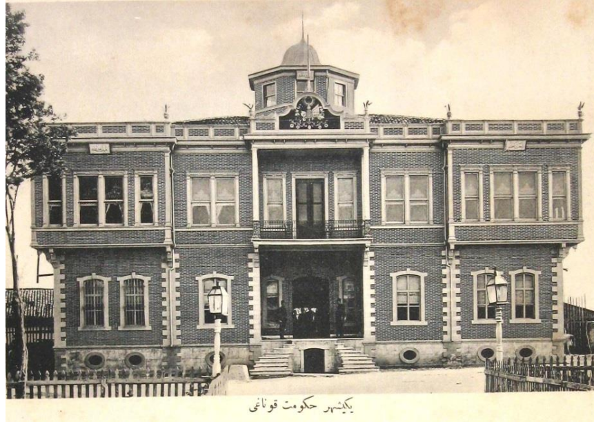
Resim 16: Bursa-Yenişehir Kazası Hükümet Konağı (HVS 1325: 455)
