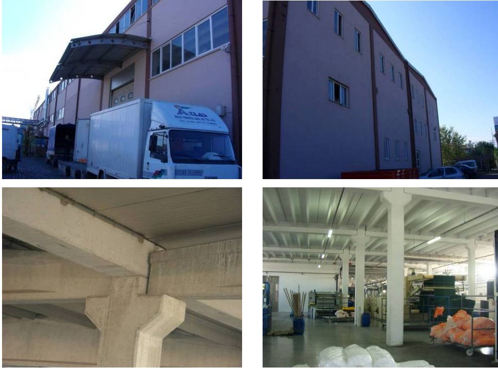
Şekil 3.9. Bina Ç7'nin saha çalışmaları sırasında çekilen fotoğrafları
