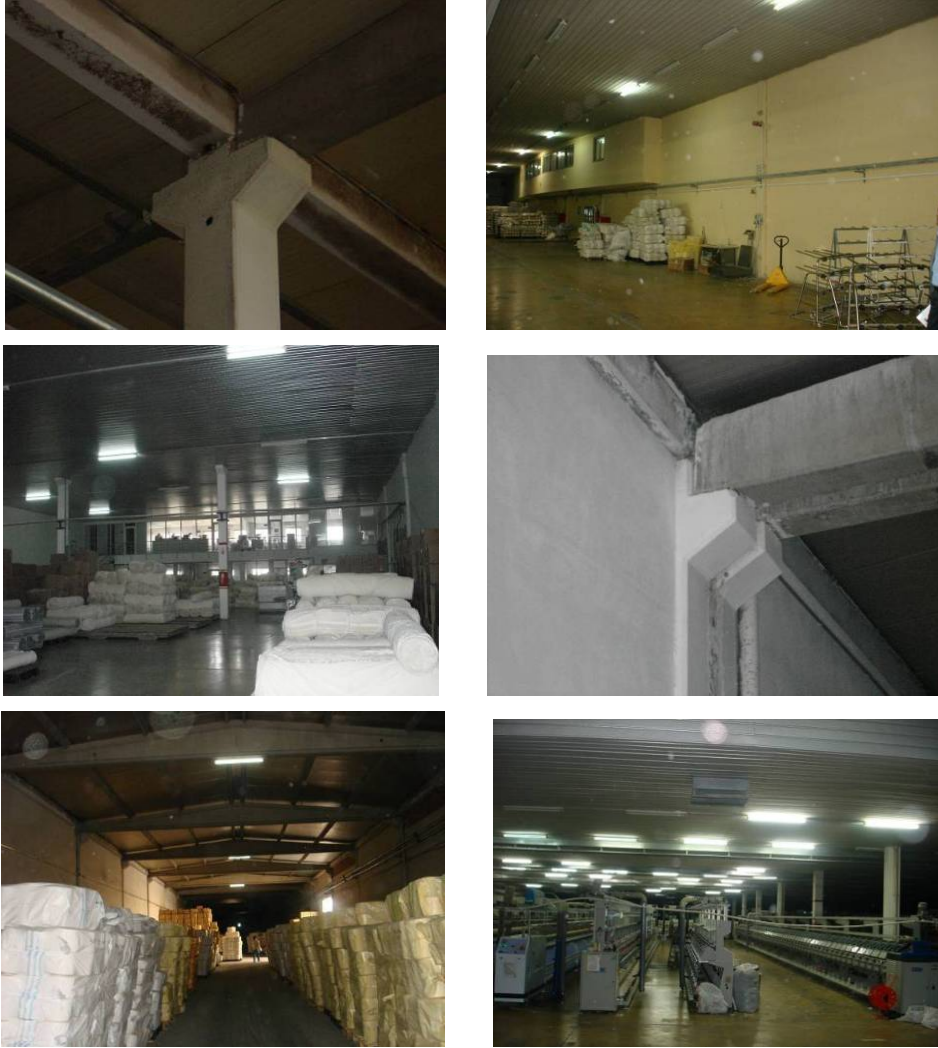
Şekil 3.6. Bina T2'nin saha çalışmaları sırasında çekilen fotoğrafları
