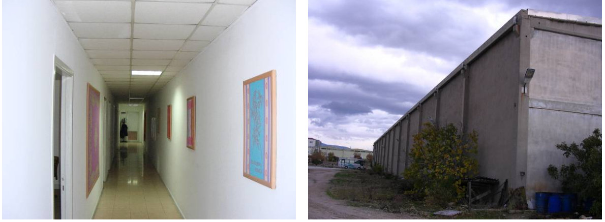
Şekil 7.1. Bina T19'a ait sahadan çekilen fotoğraflar
