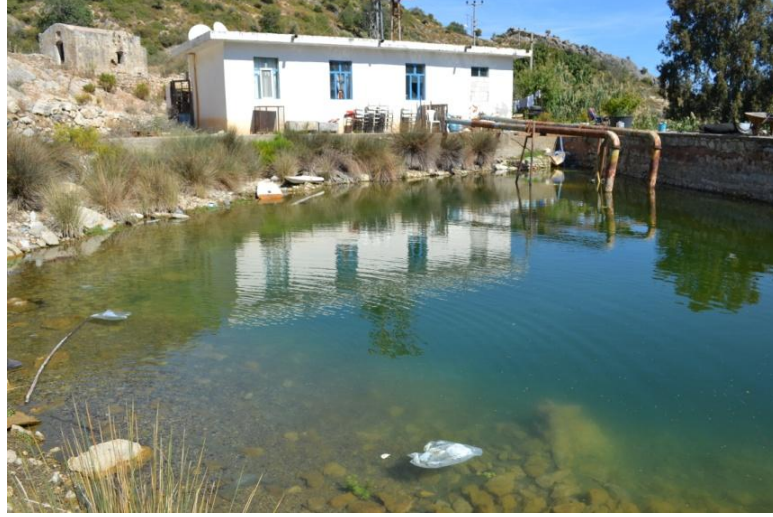
Foto 3.5: Kargı-1 kaynağı Liman kaynağından görünüm (KD'ya bakış).
