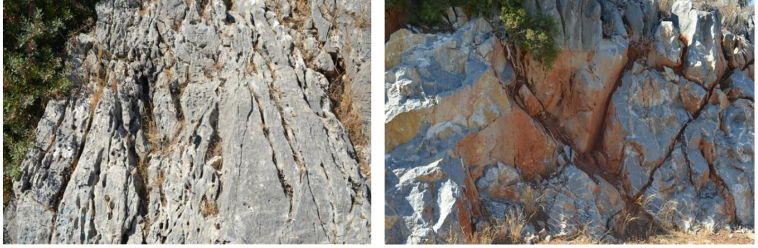
Foto 2.5: Karabögürtlen formasyonu kireçtaşlarındaki çatlak ve çözünme boşlukları (Kargı-Datça yolu).
