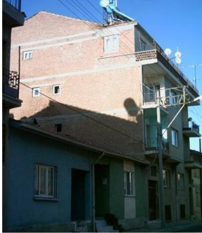
Şekil 4.1 Uşak merkezde 4 kat +çatı piyesli yığma bir bina
