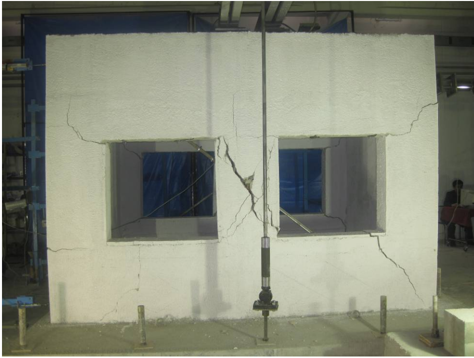
Şekil 6.112. İlerleyen çevrimlerde oluşan çatlaklar
