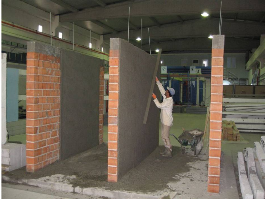
Şekil 3.25. Sıvanın yapılması
