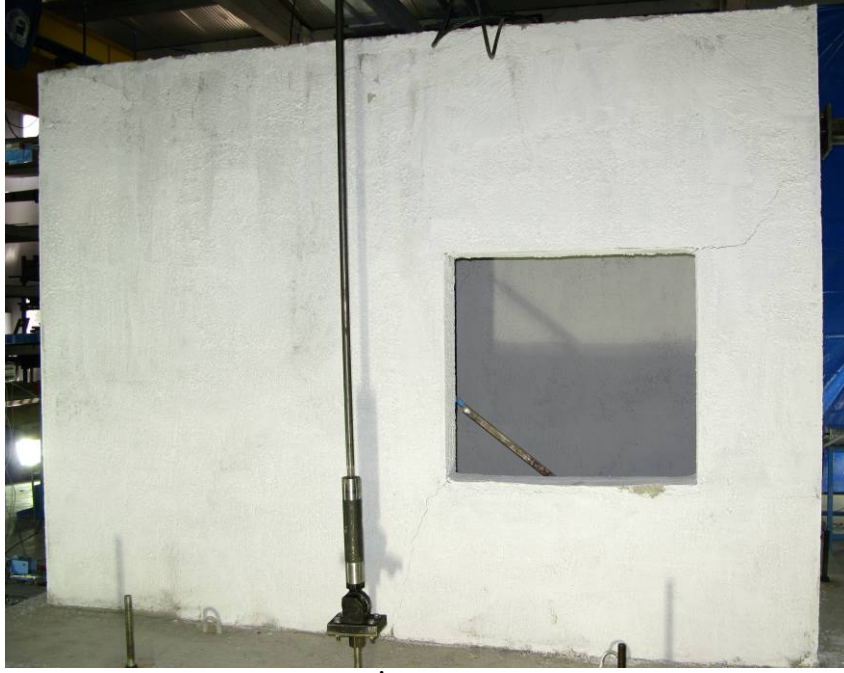
Şekil 6.101. İlk çatlak oluşumları
