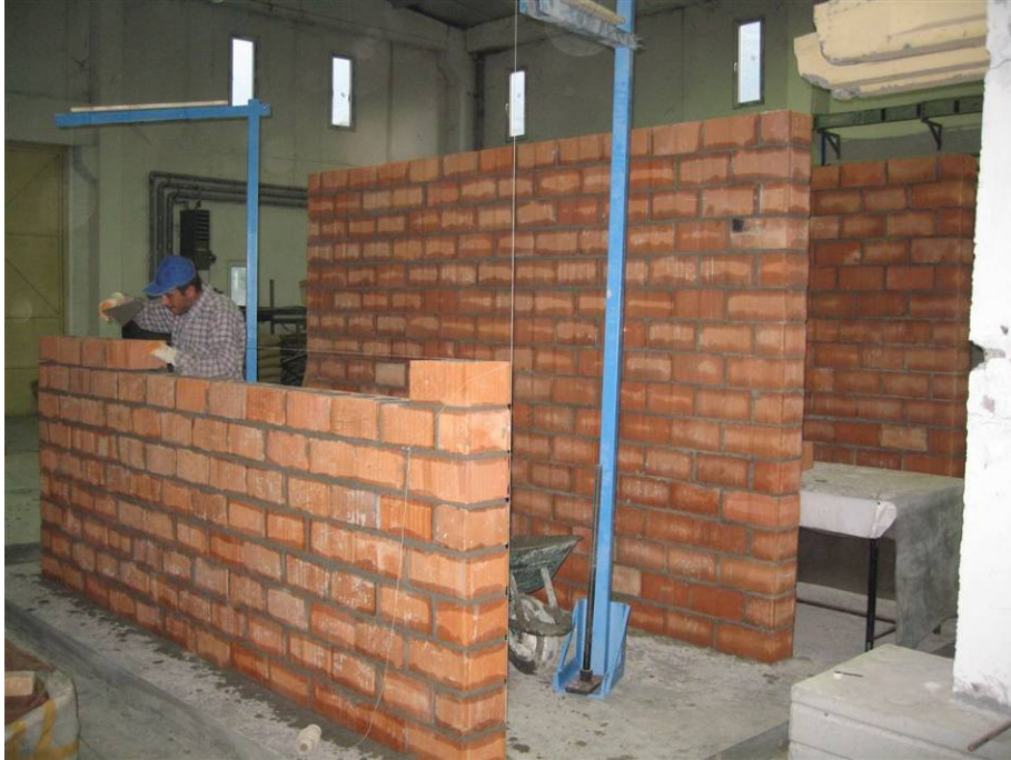
Şekil 3.23. Tuğla duvarların üretilmesi
