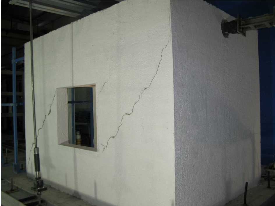
Şekil 6.82 Onarılmak üzere hasar verilen yapının (YB2A) deney sonu görünümü
