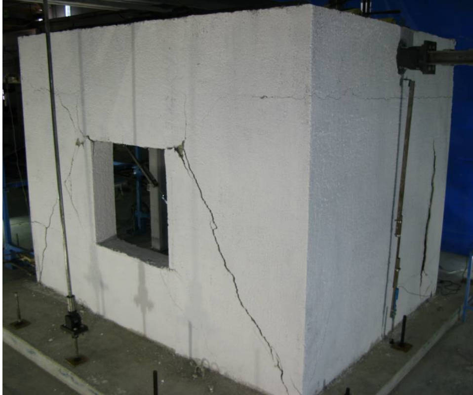
Şekil 6.92. İlerleyen çevrimlerde oluşan çatlaklar
