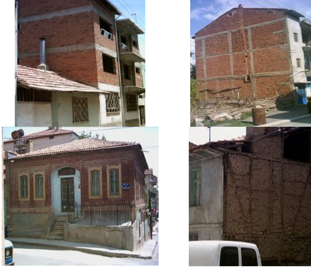
Şekil 4.7 Çeşitli yığma taşıyıcı sistem yapı tipleri
