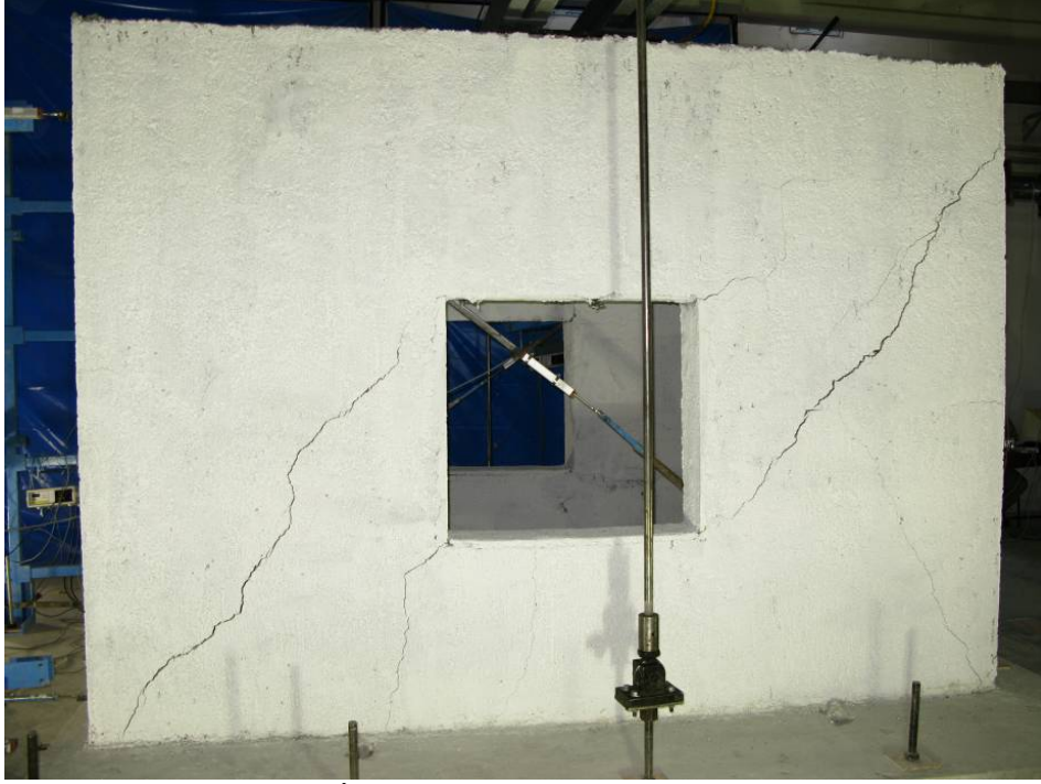
Şekil 6.97. İlerleyen çevrimlerde oluşan çatlaklar
