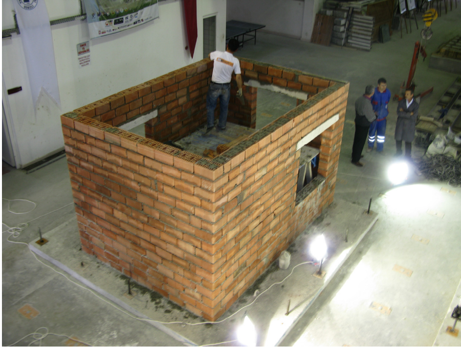
Şekil 3.19. YB2 ve YB5B Numunesinin yapım aşamasındaki görünümü
