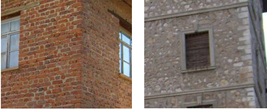
Şekil 4.22 Doğru köşe birleşimine örnekler
