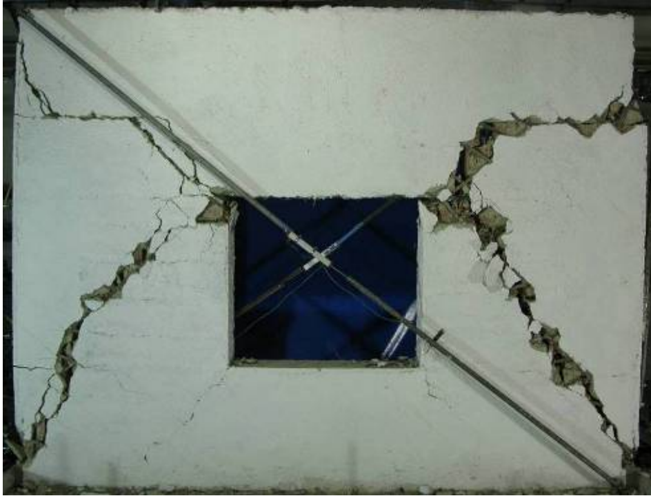
Şekil 6.66. Deney sonundaki hasar durumu
