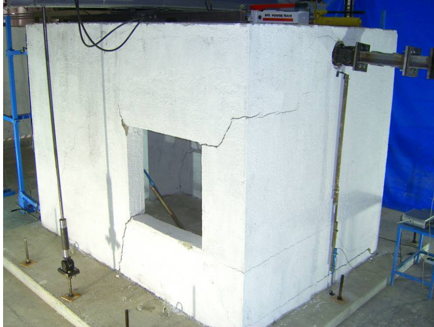
Şekil 6.102. İlerleyen çevrimlerde oluşan çatlaklar
