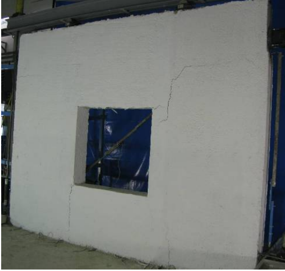
Şekil 6.73. Ardışık çevrimlerde oluşan çatlaklar
