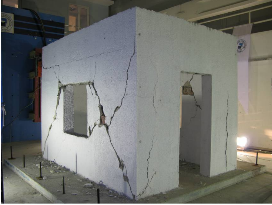
Şekil 6.93. Deney sonunda ortaya çıkan hasarlar
