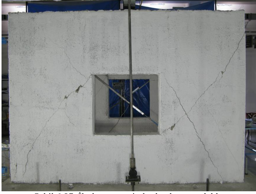
Şekil 6.87. İlerleyen çevrimlerde oluşan çatlaklar
