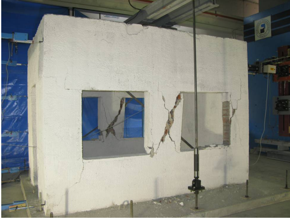
Şekil 6.108 Deney sonunda ortaya çıkan hasarlar
