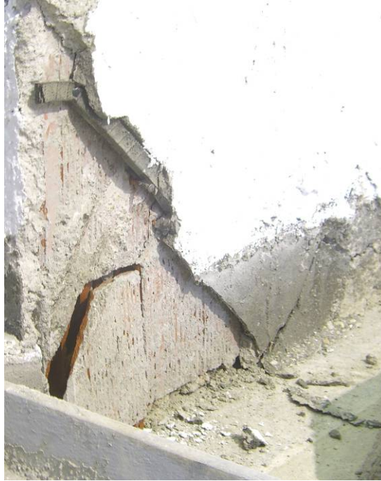
Şekil 6.22. Ezilen bölgelerdeki hasar
