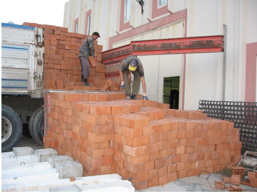
Şekil 3.20. Tuğlaların istiflenmesi
