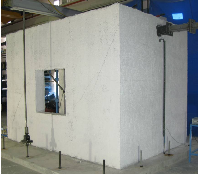
Şekil 6.86. İlk çatlak oluşumları
