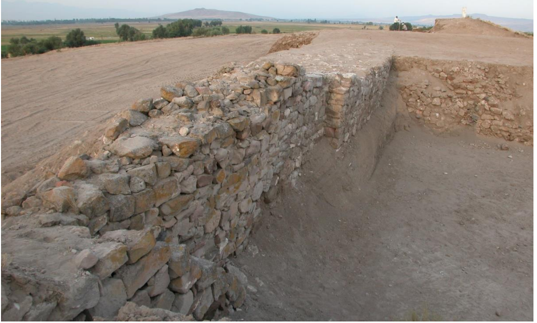
Fig. 12: Sur ve Merdivenleri (Güney Kısım)
