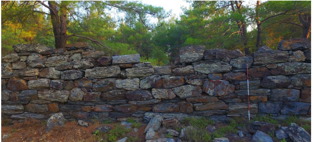
Figür 14. Duvar 3 Güney Görünüşü
