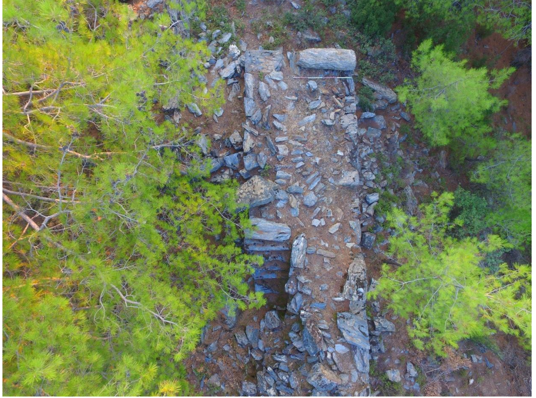
Figür 66. Bindirmeli Kapı 2, Basamaklar ve Üzerindeki Platformun Görünüşü
