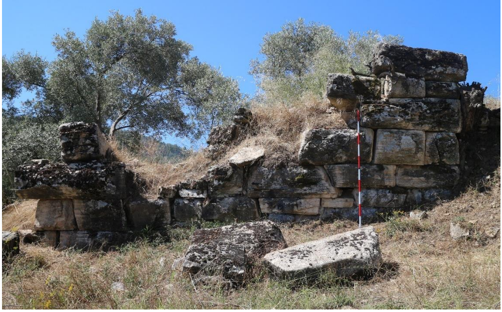
Figür 54. Duvar 10 Doğu Görünüşü
