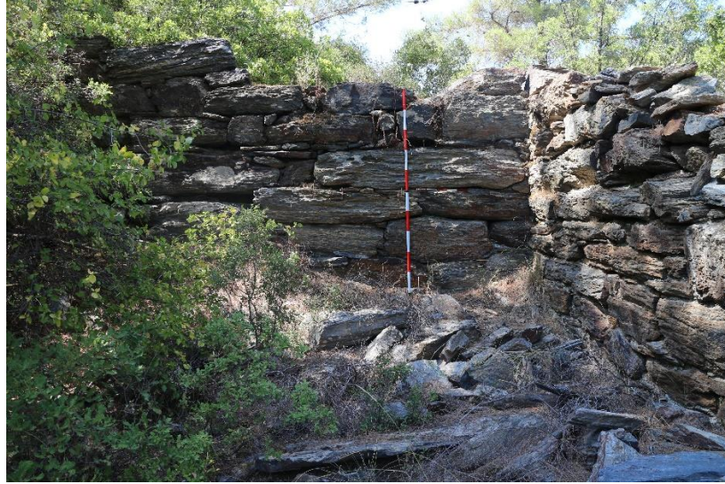
Figür 8. Duvar 1 Doğu Görünüş
