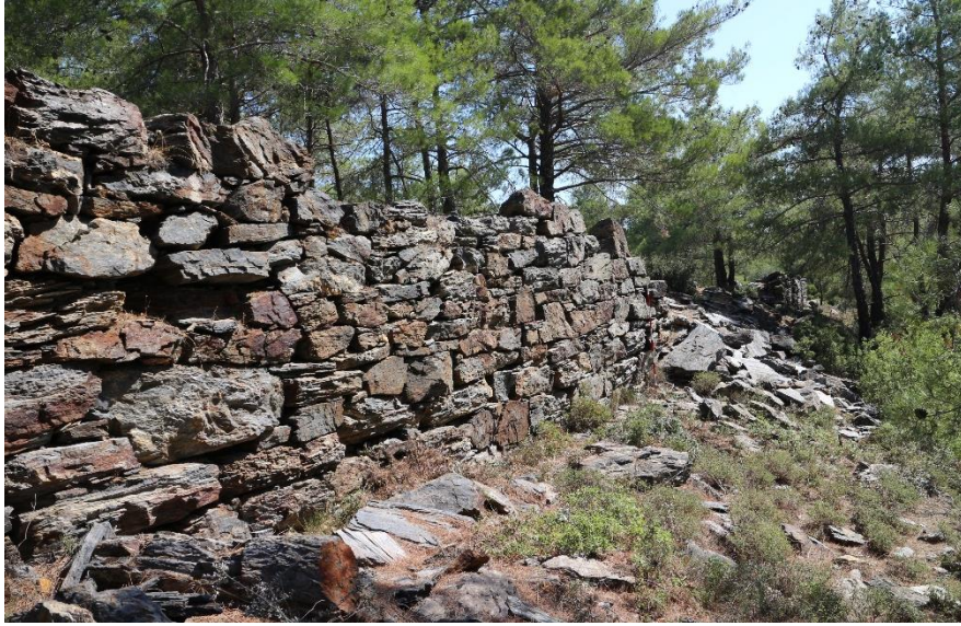
a. Duvar 3 Batıdan Doğuya Görünüşü
