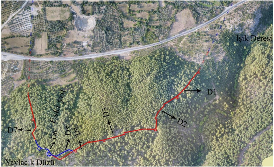
Figür 7. Kadıkulesi Savunma Duvarları
