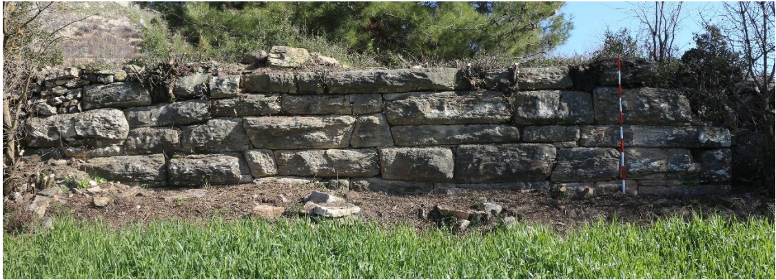
Figür 52. Duvar 9 Güney Görünüş
