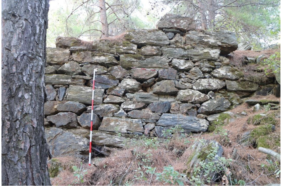
Figür 20. Duvar 7 Doğu Görünüş
