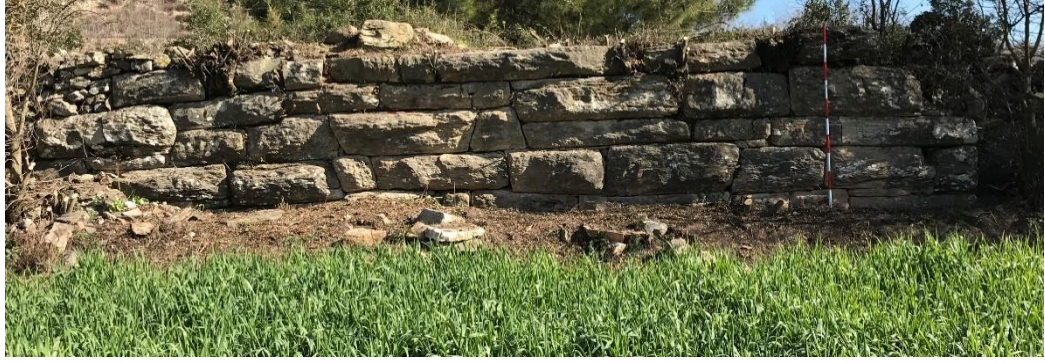
Figür 80. Duvar 9, Güneyden Görünüş
