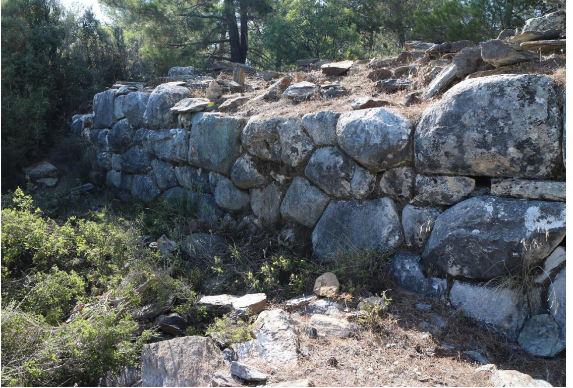
Figür 77. Duvar 5 Genel Görünüş
