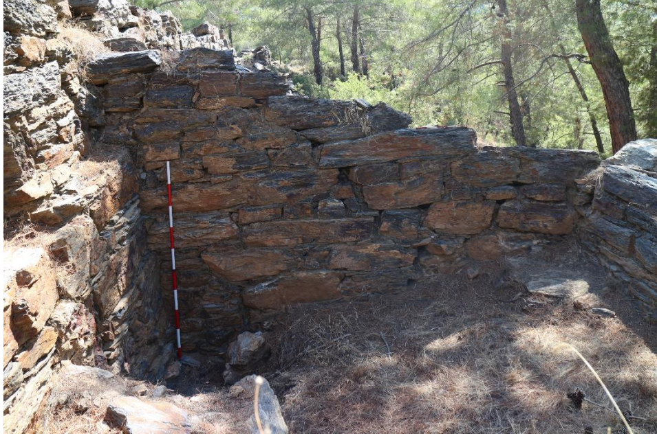
Figür 70. Kule 4'in Doğu Duvarının İç Görünüşü
