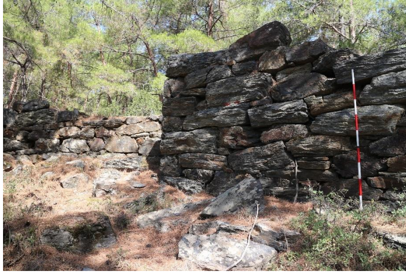
b. Duvar 4 ve Dirsek 3'ün Güney Görünüşü
