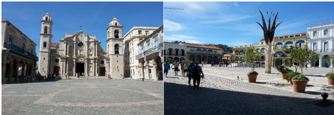
Fotoğraf 2.11. Eski Havana’da restorasyon meydanlardan başlarken, Katedral Meydanı ve Eski Meydan gibi 5 meydan düzenlenen ilk mekânlardır
