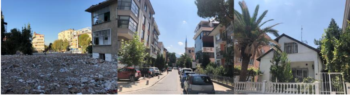
Fotoğraf 3.19. Sırapapılar Mahallesi'nde 1583 Sokak
