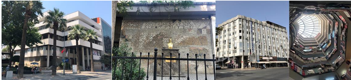
Fotoğraf 3.12. Kent Merkezindeki Cengiz Bektaş eserlerinden örnekler: Merkez Bankası şube binası, Hacı Halil Bektaş İlkokulu, Babadağlılar Çarşısı Kaynak: O. Donat Arşivi (2022)
