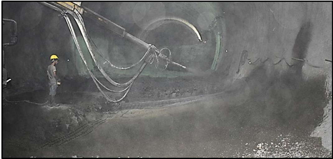
Şekil 3.9: Tünel bölgesine püskürtme beton uygulaması
