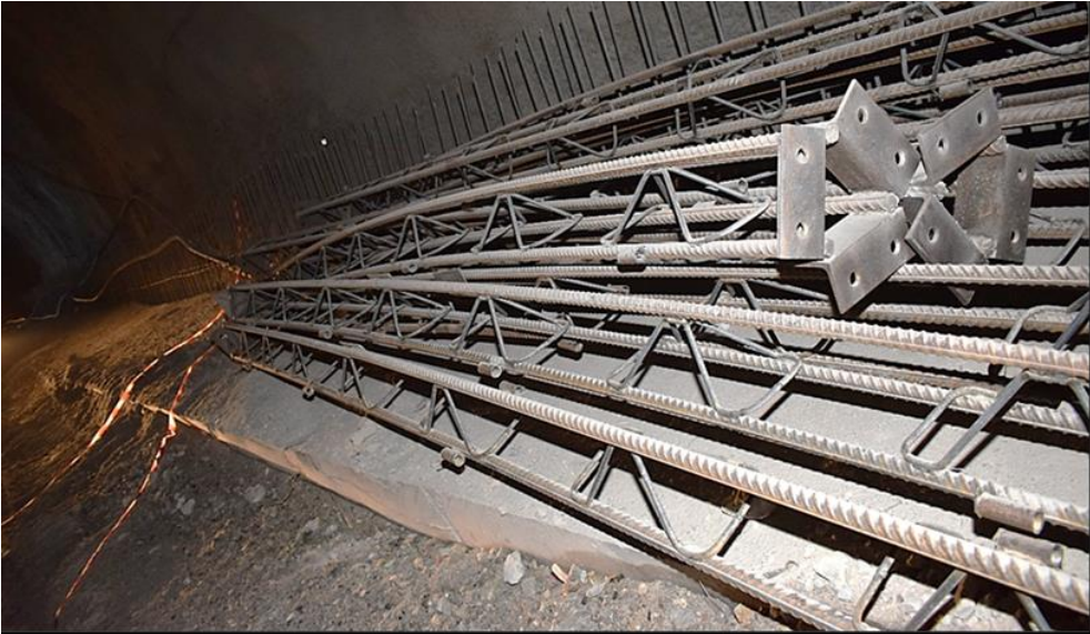
řekil 3.5: Honaz Tüneli'nde kullanılan kafes profil destek elemanları
