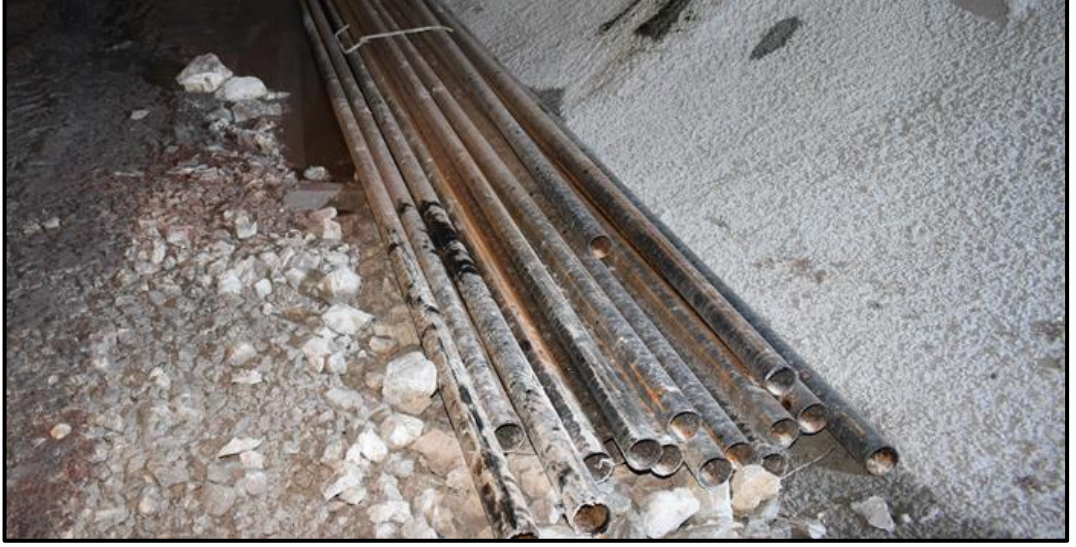
Şekil 3.10: Honaz Tüneli’nde kullanılan süren destek elemanları
