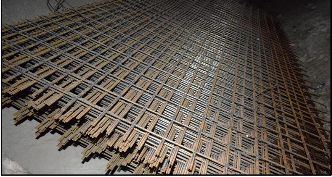
Şekil 3.8: Honaz Tüneli'nde kullanılan çelik hasır destek elemanları
