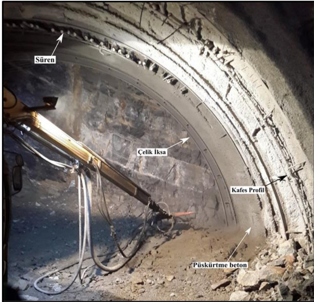
Şekil 3.3: Honaz Tüneli kazı sonrası uygulanan destekleme elemanları
