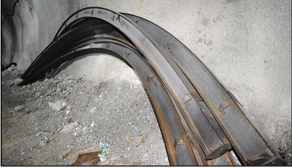
řekil 3.4: Honaz Tüneli'nde kullanılan elik iksa destek elemanları
