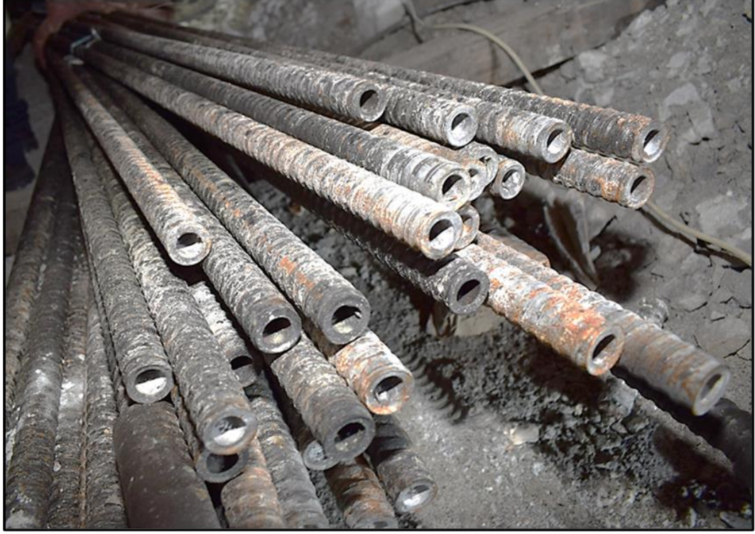
Şekil 3.6: Honaz Tüneli'nde kullanılan kaya bulonu destek elemanları
