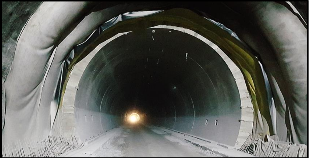
Şekil 3.11: Honaz Tüneli kaplama beton uygulaması
