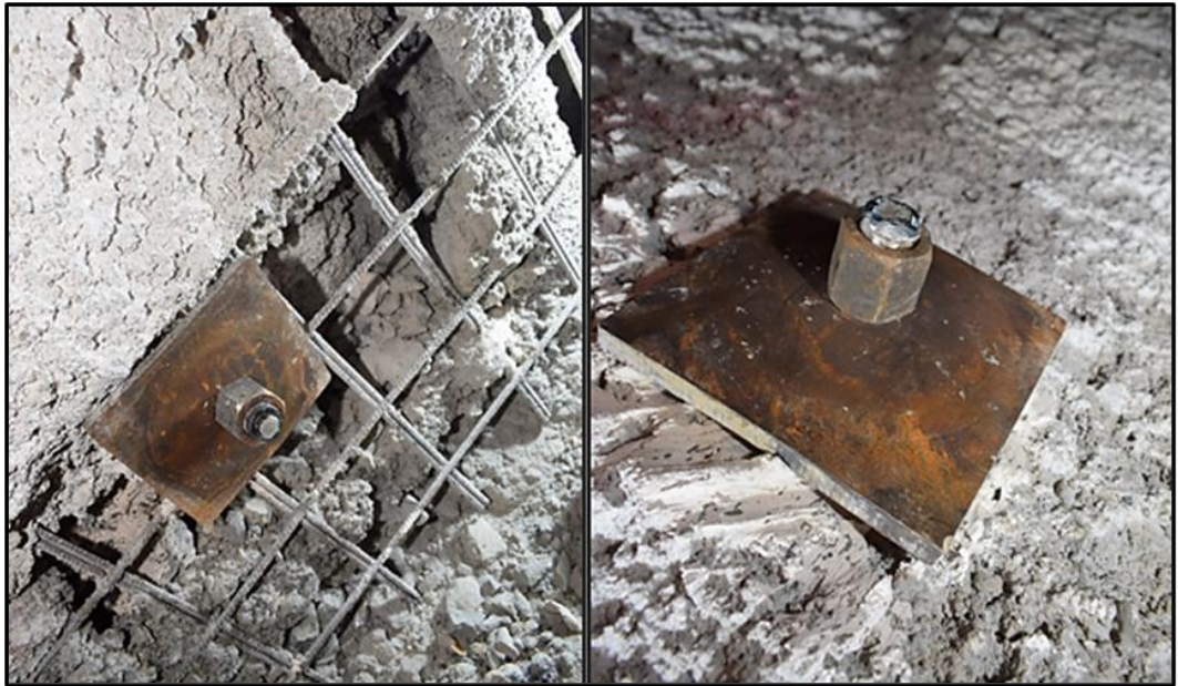
Şekil 3.7: Tünelde bölgesinde yerleştirilen kaya bulonları
