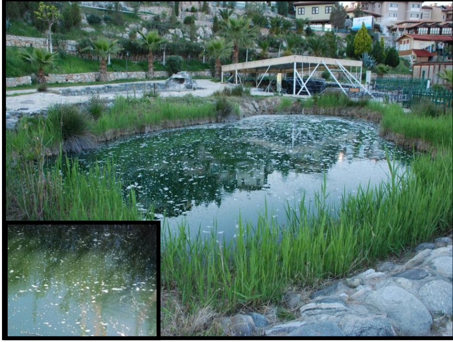
Şekil 2.5: Umut termal 4. istasyon görünüm
