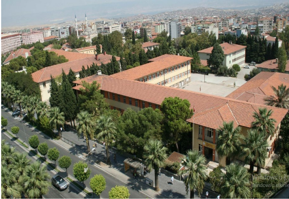
Fotoğraf 46. Yıkılan Kız Endüstri Meslek Lisesi Binası (mmo.org.tr)
