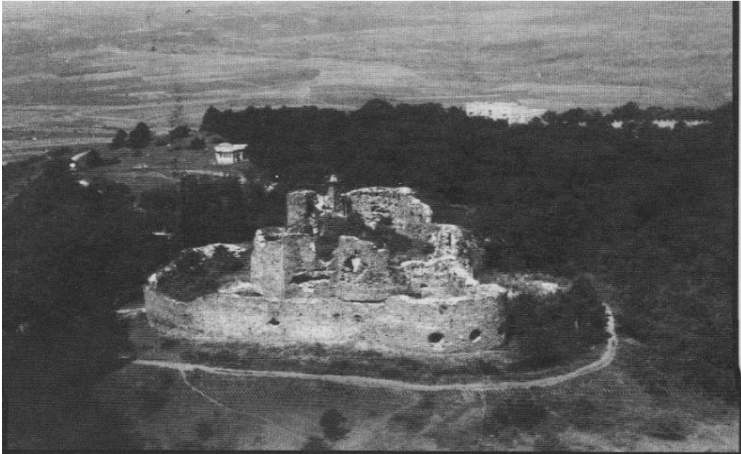
Resim 6: Havale-Avala (Güzelcehisar Kalesi) 419
