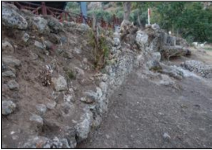
Resim 6: Surlardan genel görünüş.
