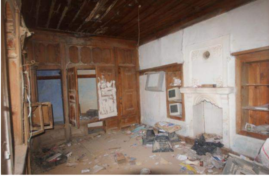
Foto. 21. Kuzeybatıdaki Odanın Görünüm
