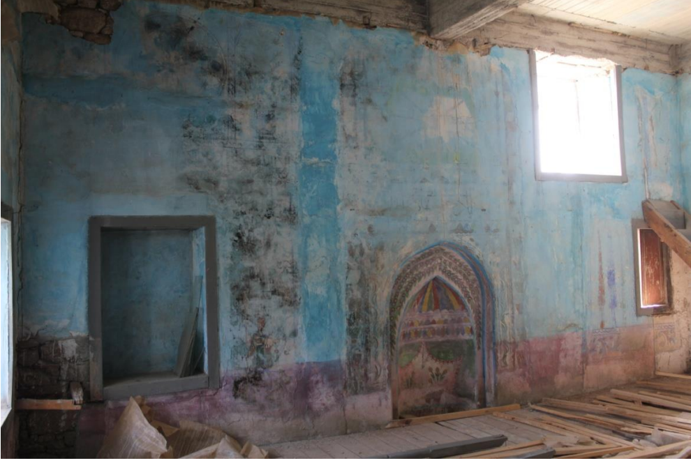
Fotoğraf 25: Künar Köyü Camii, güney duvarı
