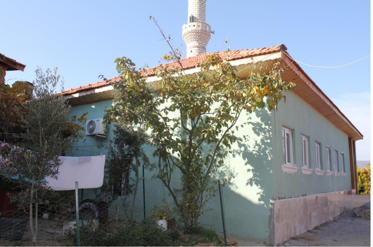
Fotoğraf 3: Esenkaya Köyü Camii, güney ve doğu cephesi
