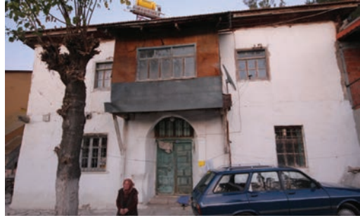
Fotoğraf 2: Batı cephe.
