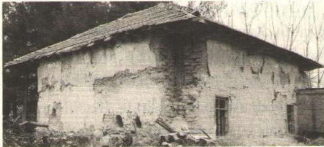
Fotoğraf 3: Güneybatı cephe
