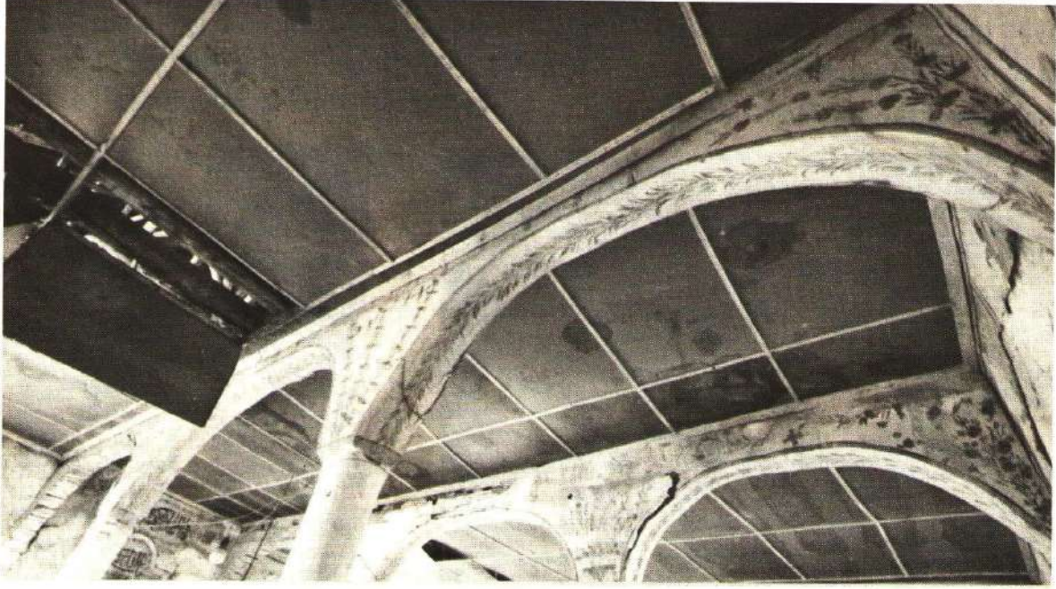
Fotoğraf 16: Harim mekânı kemerlerin görünüşü
