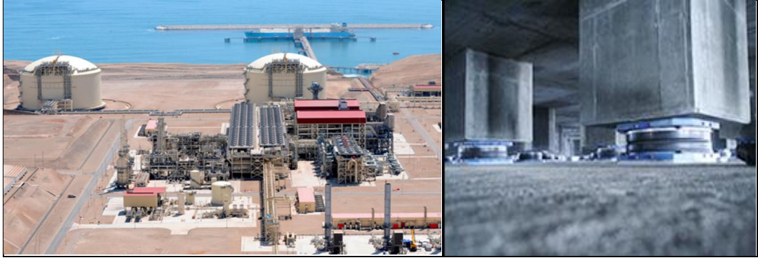
Resim 2.13: Peru Melchorita 130,000 m 3 hacimli LNG Tankları 256 FPS kullanılmıştır. D:78 m H:32.9 m. Deprem'in oluşturduğu taban kesme kuvvetini % 85 azaltmaktadır (Earthquake Protection Systems 2008).
