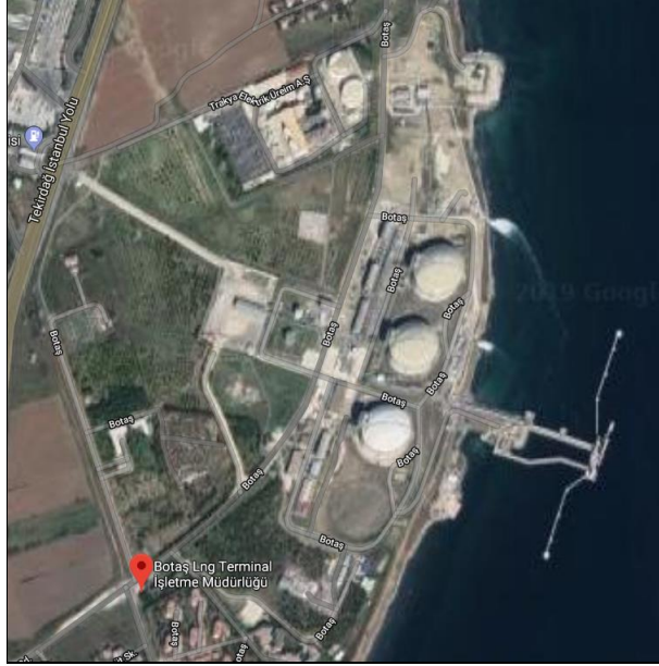
Resim 4.1: Marmara Ereğlisi BOTAŞ Tesisi LNG Tankları
