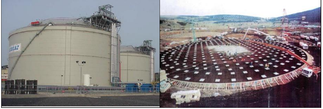
Resim 2.11: İzmir Aliğa Egegaz 140,000 m 3 hacimli LNG Tankları Her biri için 112 LRB 241 HDRB kullanılmıştır. D:85 m H:35 m (www.terbayinsa.com).
