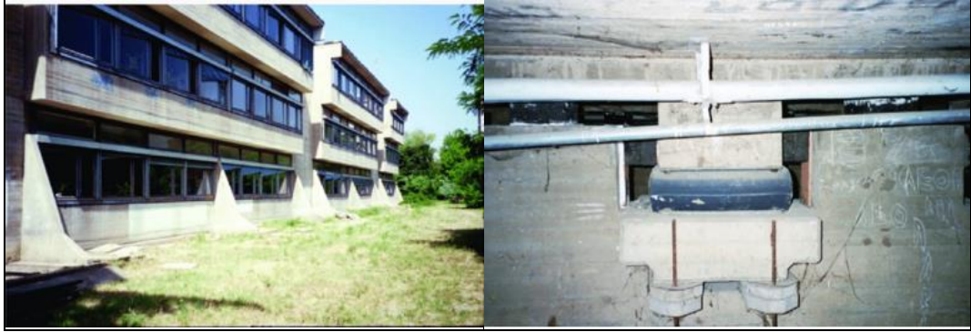
Resim 3.1: Dünya’da ilk izolatörlü yapı 1969’da Makedonya’da yapılan Pestalozzi ilkokul binası (Farzad ve Kelly 1999).
