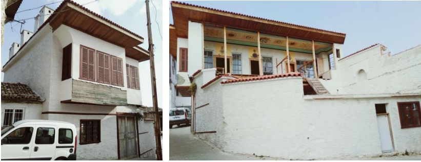
Fot.1-2: Karaahmetler Evi, kuzey, batı ve güney cephe
