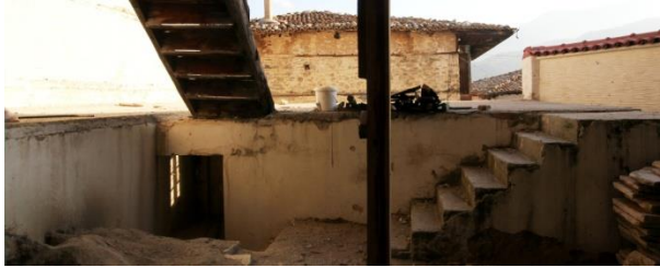
Fot.4: Avlu Duvarına Bitişik Oda ve Merdivenler
