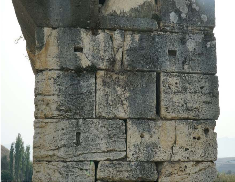
Resim 20: Asopos köprüsü ayaklarında iskele kurma delikleri.
