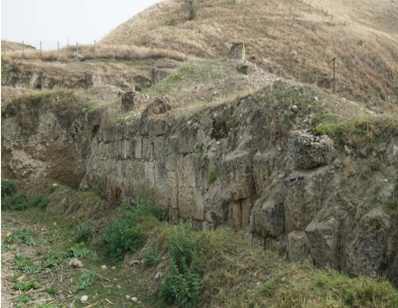
Resim 8: Asopos Köprüsü'nün doęu yakası masif kuzey istinat duvarları.
