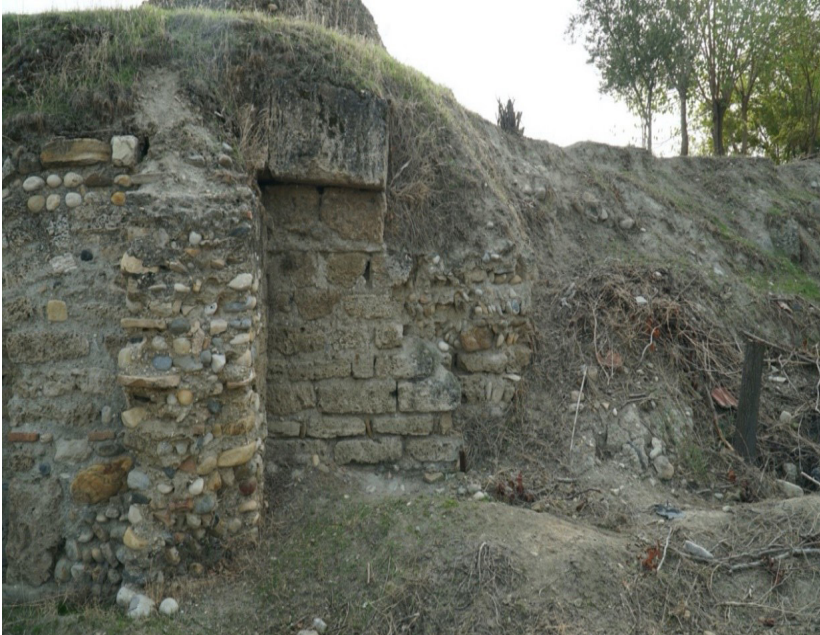
Resim 22: Asopos Köprüsü'nün batı uzantısında kuzey istinat duvarı örgü sistemi ve çay taşı dolgu, solda duvara bitişik tonozlu mezar kalıntısı.
