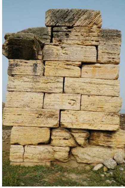
Resim 13: Asopos K pr s 'n n ayakta kalabilen doĐu ayaĐının korniŐiyle kuzeyden g r n m , duvar  rg  sistemi ile blok aŐınmaları.
