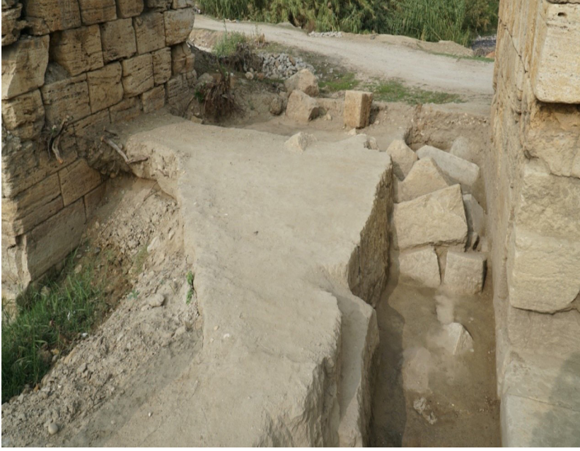
Resim 17: Asopos Kprüsü'nde geniŐ kemerin batısında üçüncü kemer ayaklarında yapılan sondaj çalıŐması ve çalıŐmalarda ortaya çıkartılan kemer bloklarının bir kısmı.
