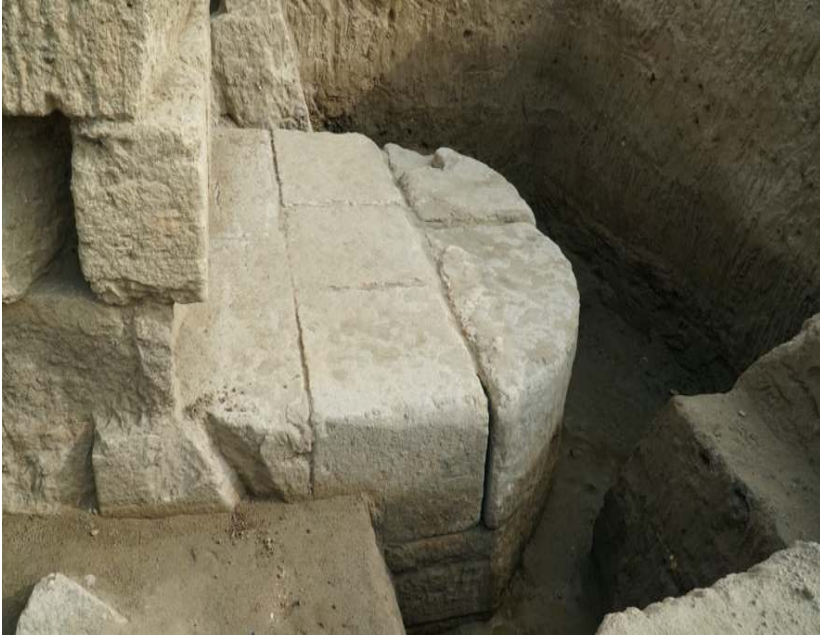
Resim 18: Asopos Kprüsü'nde geniŐ kemerin batısında üçüncü kemerin doĐu ayaĐının güney dibinde yapılan sondaj çalıŐmalarında ortaya çıkartılan ucu yarım daire selyaran çıkıntısı.
