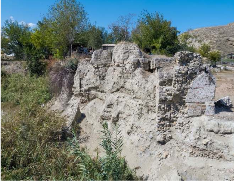
Resim 21: Asopos Köprüsü'nün batı uzantısında tahrip ve heyelan sonunda kalabilen opus caementicum istinat duvarları, yol döşemesi ile kuzeyde bitişik freskli-tonozlu mezar kalıntısı.
