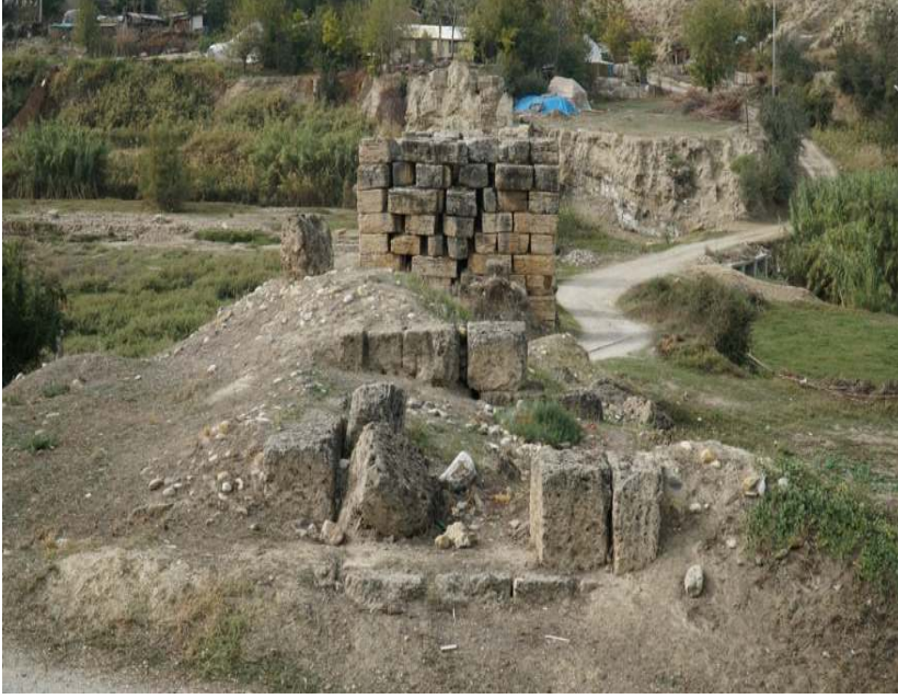
Resim 7: Asopos Köprüsü'nün doęu yakası istinat duvarları ve iç kısımlarında belirli aralıklarla yapılan merdiven basamaęı řeklinde sandık tipli yapılan duvar saęlamlařtırma baęlantıları.
