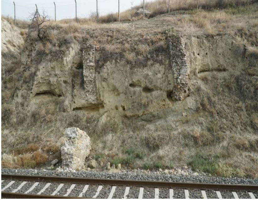
Resim 5: Asopos Kprüsü'nde vadinin doĐu yamacında opus caementicium istinat duvarları ve i dolgusu, batı nde 1888-89 yılı tren yolu tahribatı ve mevcut DDY hattı.
