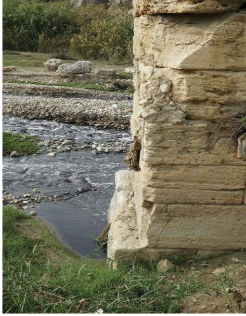
Resim 19: Asopos Köprüsü'nde geniş kemerin batısında üçüncü kemerin batı ayağının güney dibinde tahrip olan selyarana ait blok çıkıntısı ve Asopos Nehri'nin günümüzdeki yatağı.
