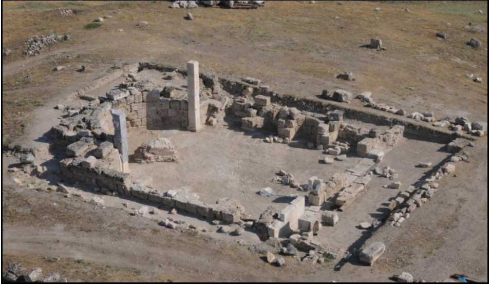
Resim 7: C Yapısı Kazı Sonrası Havadan görünüm
