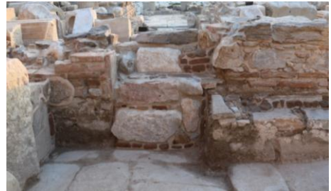
Resim 12: Narteks Duvarı, Uygulama Çalışmaları Sonrası
