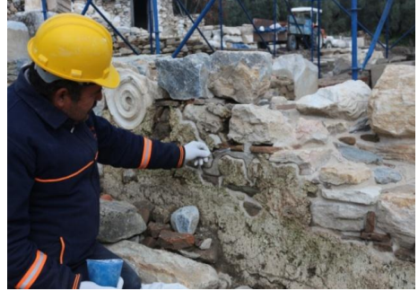
Resim 10: Derzleme ve Sağlama Çalışmaları
