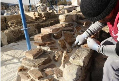
Resim 9: Derzleme ve Sağlama Çalışmaları
