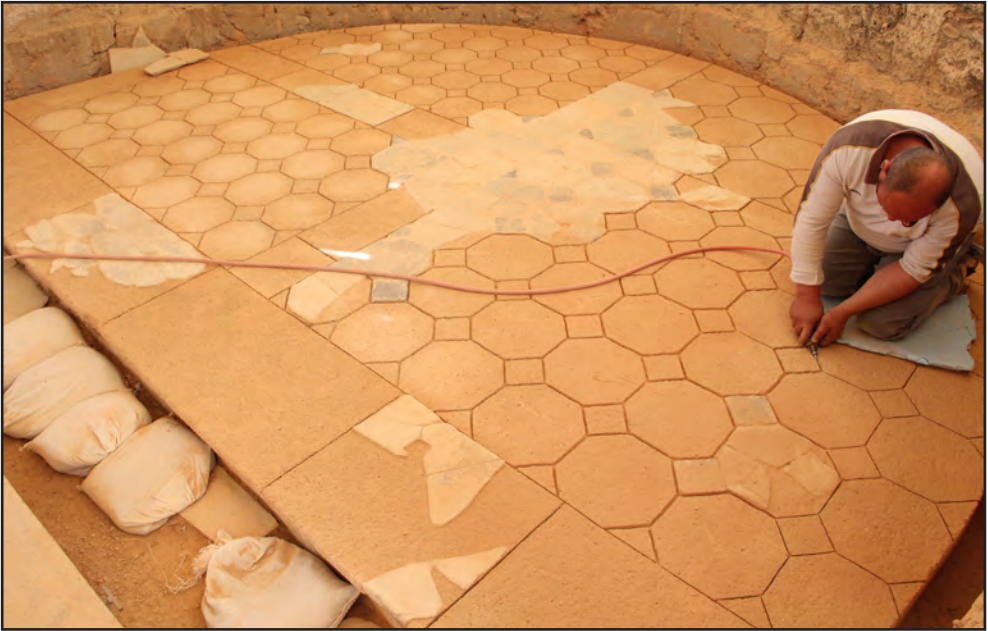
Resim 4 - Opus Sectille döşemelerde kireç harçlı tamamlama uygulaması.
