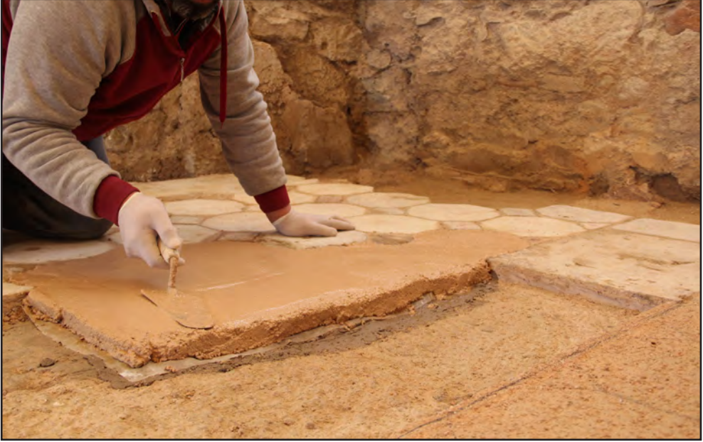
Resim 3 - Üç Katmanlı koruma harcı uygulaması.
