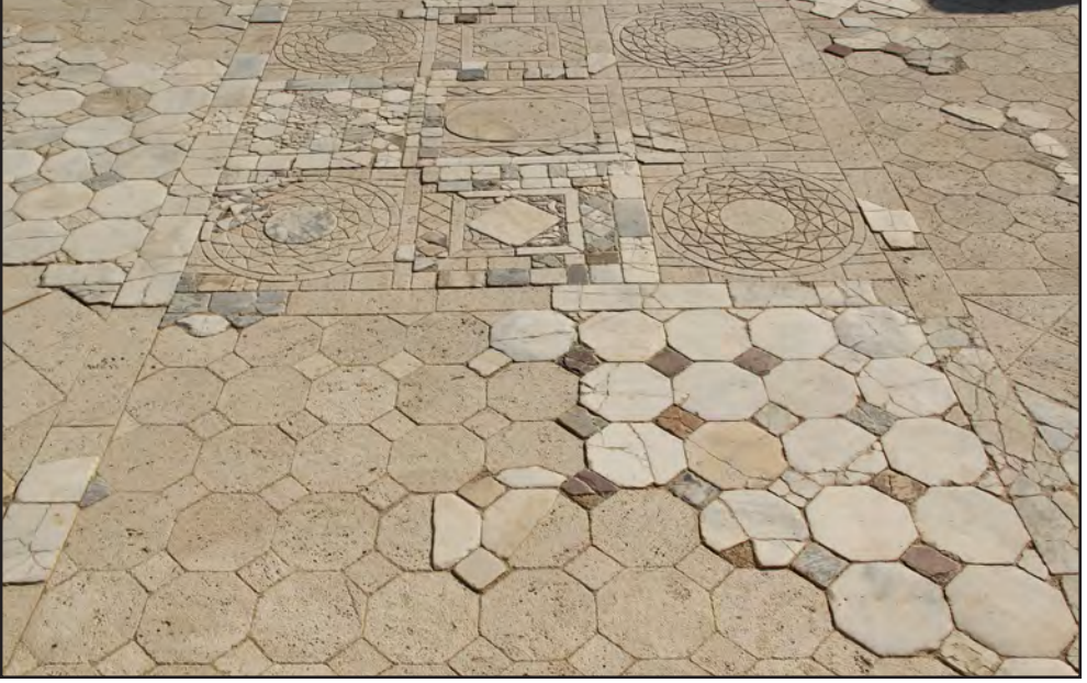
Resim 5 - Opus Sectille döşemelerde doğal taş tamamlama uygulaması.
