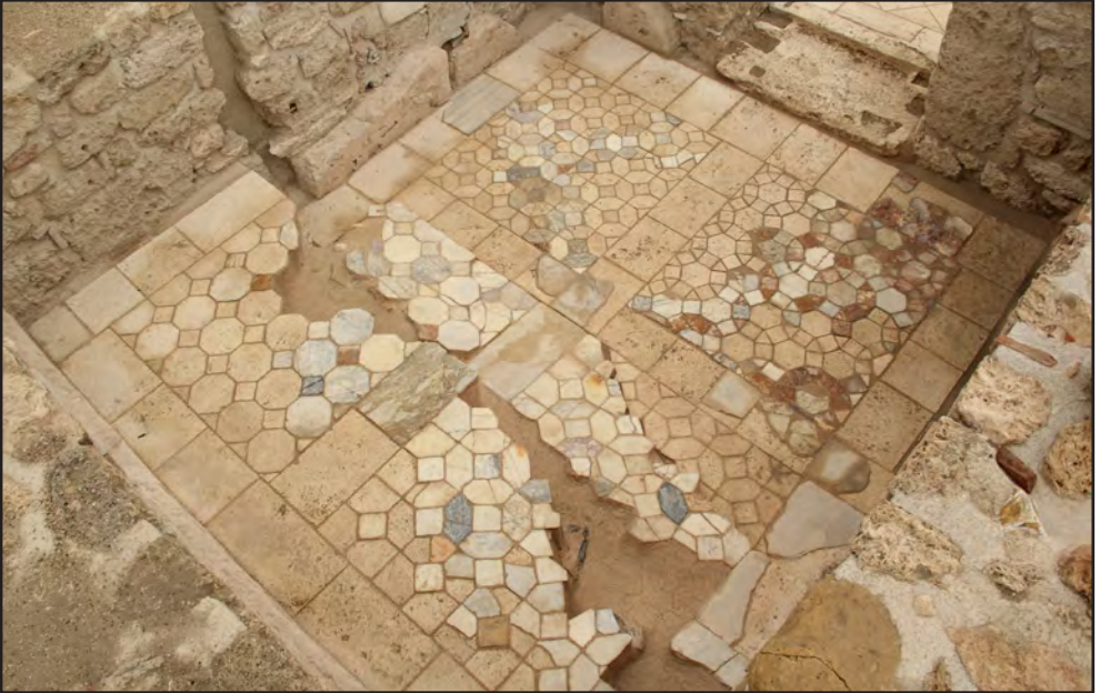
Resim 6 - Zemin ve duvarlardan takip edilen deprem kırıklarının onarım sonrası görünümü.
