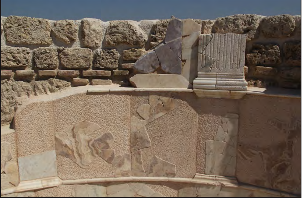
Resim 7 - Mermer duvar kaplamalarının onarım sonrası görünümü.
