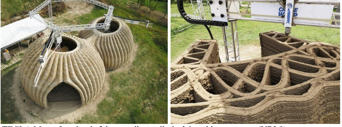
TECLA Massa Lombarda 3d yazıcı ile üretilmiş dairesel konut yapısı (URL9)
