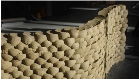
ETH Zürich Lehmag AG ve Brauchli Ziegelei AG iş birliği ile yürütülen mesh kalıp toprak inşası (URL18)
