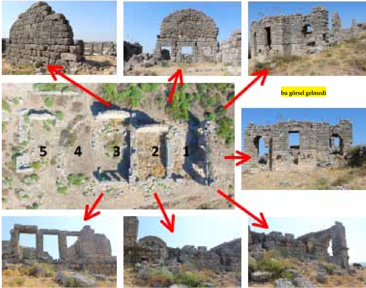
Figür 1. Sillyon Roma Hamamı, Genel Görünüm (1-5 no.lu Mekanlar)
