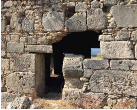
Figür 13. Pencere Lentosunda Parça Kaybı, Güney Cephe
