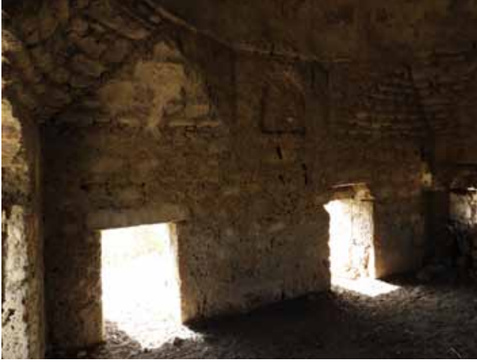
Figür 18. Taş Yüzeyinde Oluşan Kir Birikimleri
