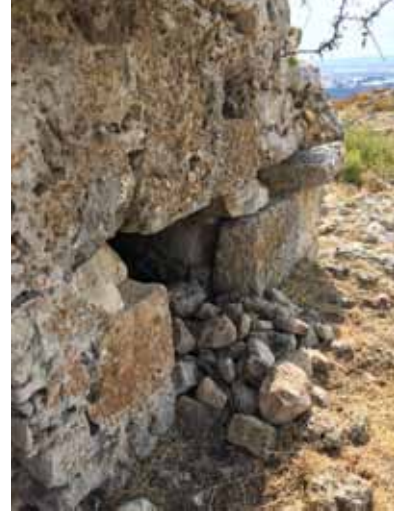
Figür 19. Taş Yüzeyinde Mikrobiyolojik Bozulmalar, Kuzey Cephe
