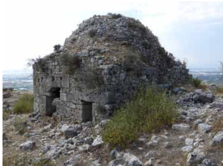
Figür 20. Yapı Etrafında Bulunan Moloz-Toprak Dolgu, Doğu-Güney Cephe
