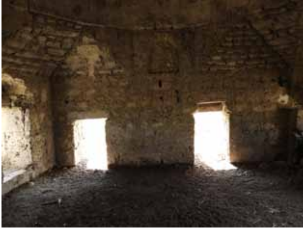
Figür 4. Üst Örtüyü Hafifletme Amaçlı Yapılan Niş Uygulaması, Batı Duvar
