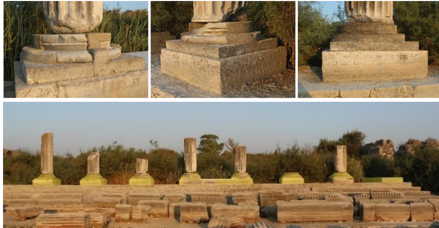
Resim 5. İonik Stoa Güney Bölüm, Sütun Kaidelerinde Çimento Bağlayıcılı Harç İle Yapılmış Olan Lokal ve Bütün Tamamlama Örnekleri (Üstte) ile Uygulama Alanlarının Genel Görünümü (Altta).
