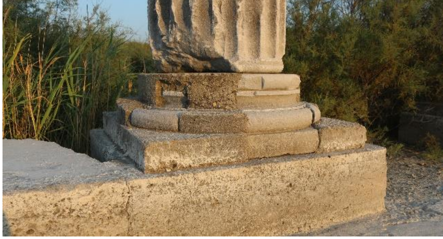
Görsel 3. Sütun Kaidesinin Tamamlanmasında Kullanılmış Olan Gri Renkli Çimentolu Harç
