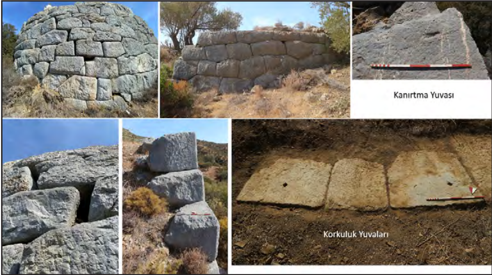
Resim 14: Yuvarlak Kule'nin detay görüntüleri ve korkuluk yuvaları.
