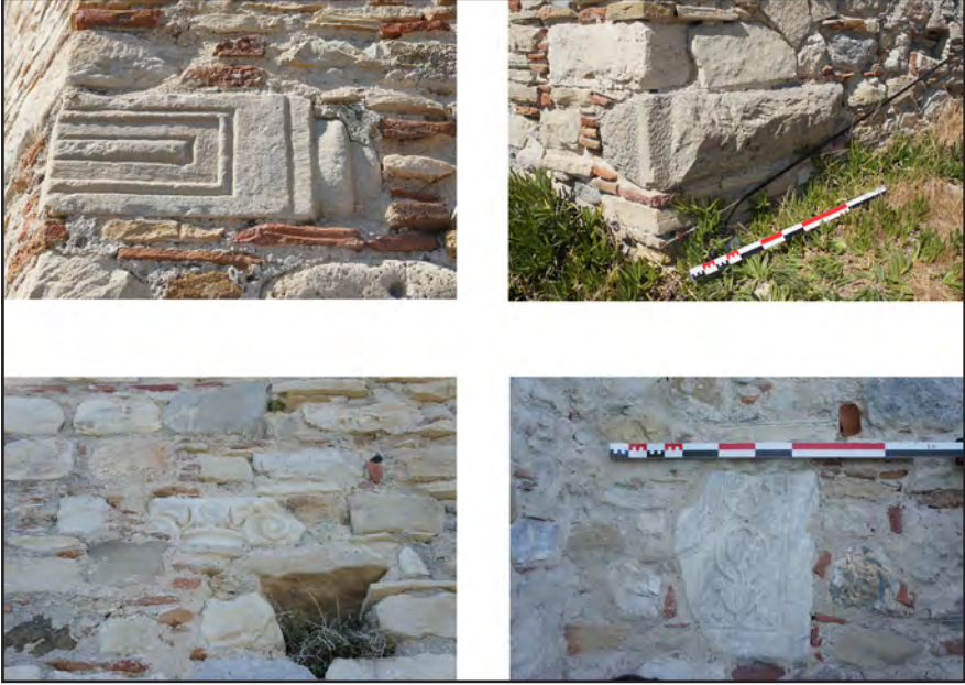
Resim 7: Güvercinada Kalesi'nin inşasında kullanılan devşirme parçalardan örnekler.
