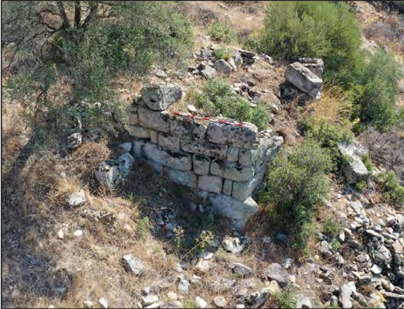
Resim 10: Çift Köşe Bağ tekniğinin uygulandığı kule.
