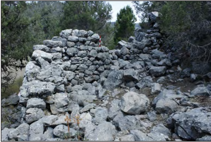
Resim 3: Oysal Muğan Yerleşimi Mekân 1 Duvarı.
