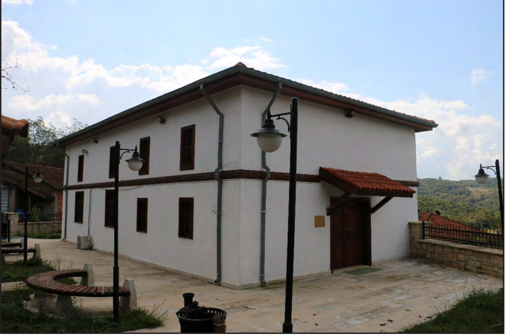
Resim 14: Bulduk Mahallesi Camii .
