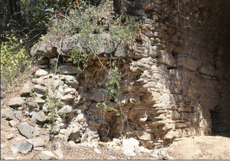
Resim 11. Güney Dış Cephe Tonoz Duvarlarında Kullanılan Harç Malzeme.
