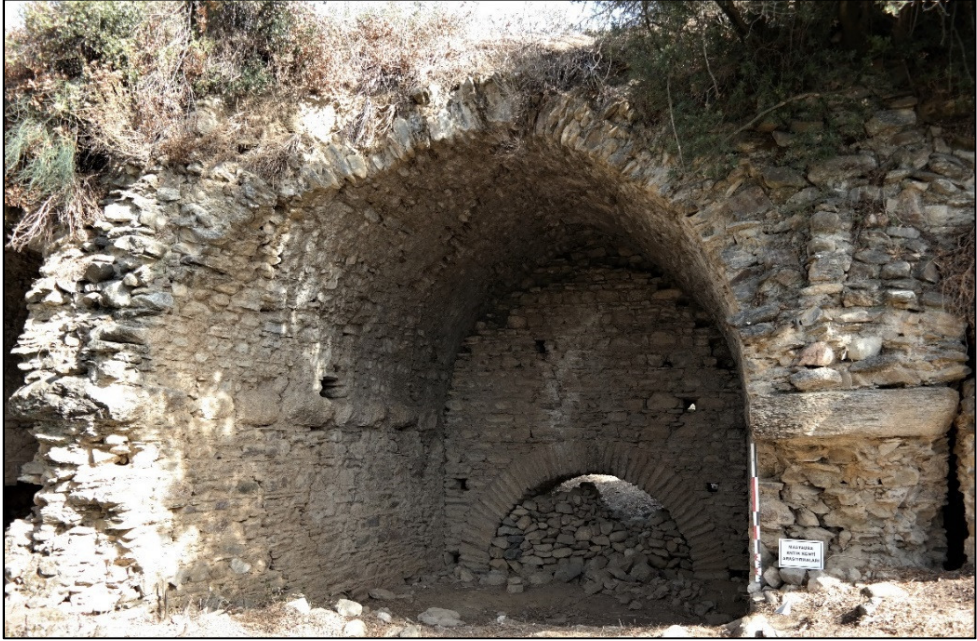
Resim 9. Güney Dış Cephe, Tonoz, Tonoz Ayağı ve Duvarında Kullanılan Taş Malzeme.
