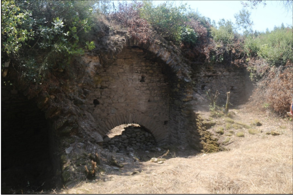
Resim 24. Güney Cephe, Orkestraya Bakan İç Cephedeki Bitkisel Gelişim.
