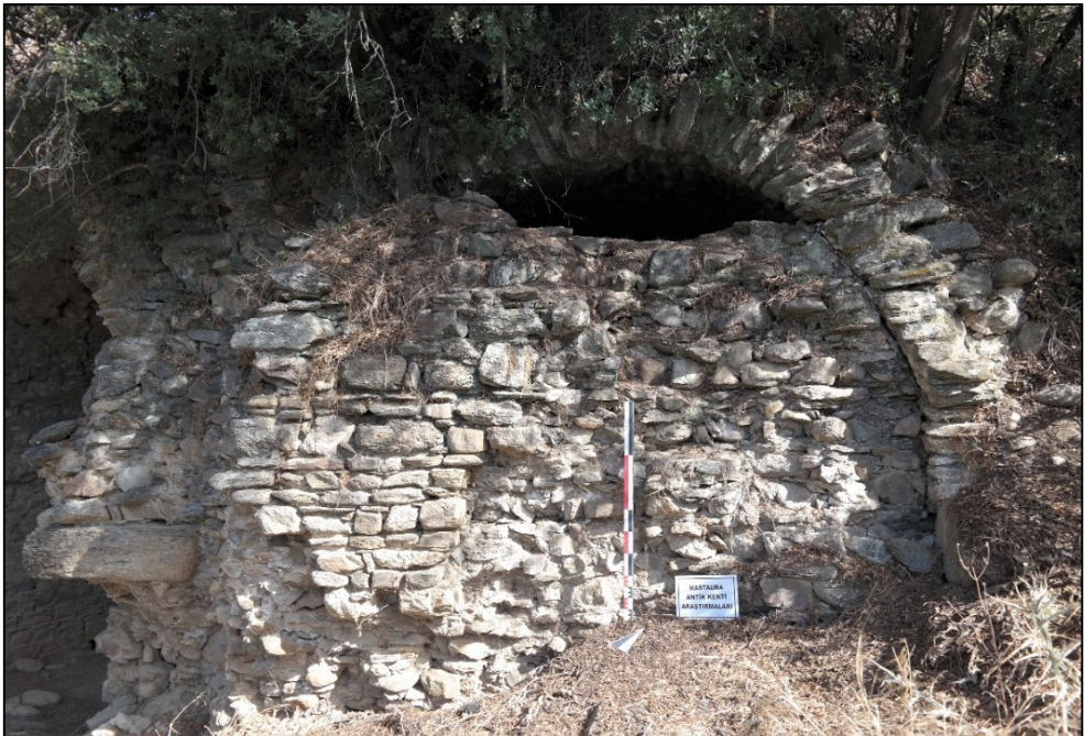
Resim 10. Güney Dış Cephe, Tonoz, Tonoz Ayağı ve Duvarında Kullanılan Taş Malzeme.
