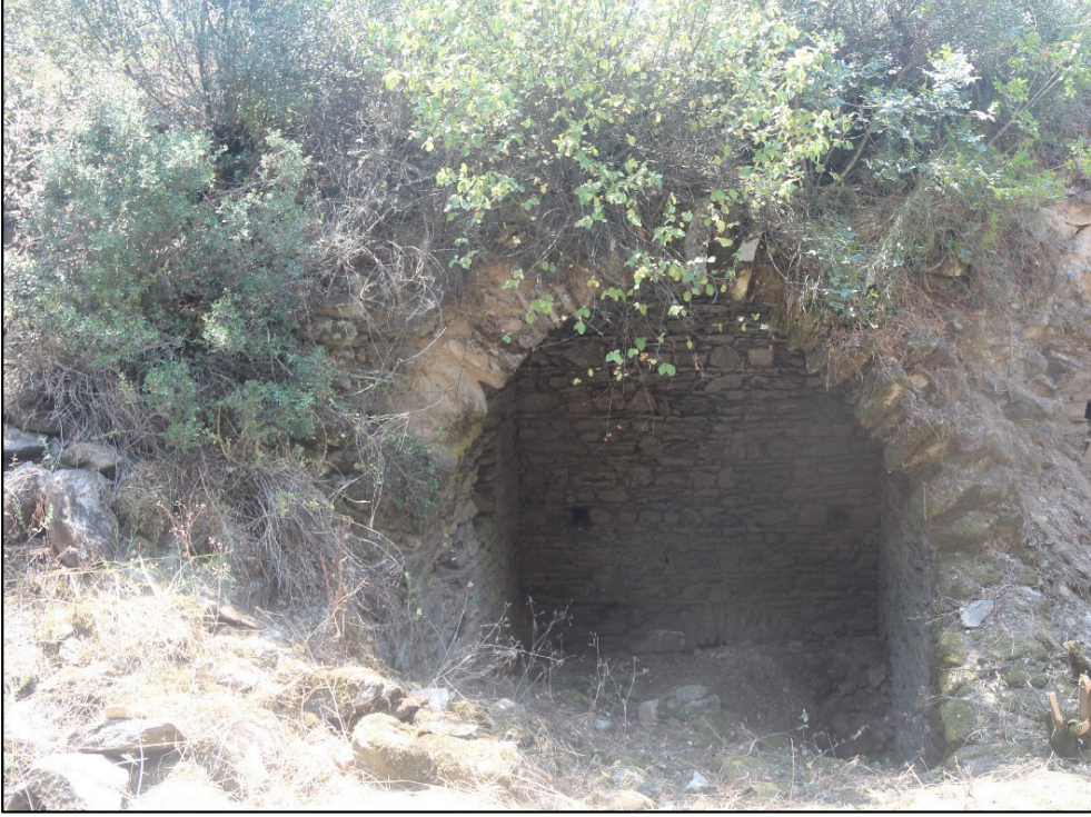
Resim 23. Güney Cephe, Orkestraya Bakan İç Cephedeki Bitkisel Gelişim.
