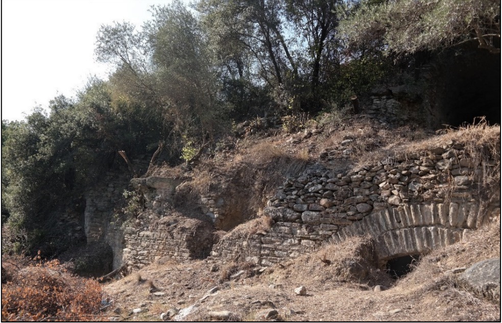
Resim 5. Üstte Güney Cephe Tonozları, Altta Dış Destek Duvarı.
