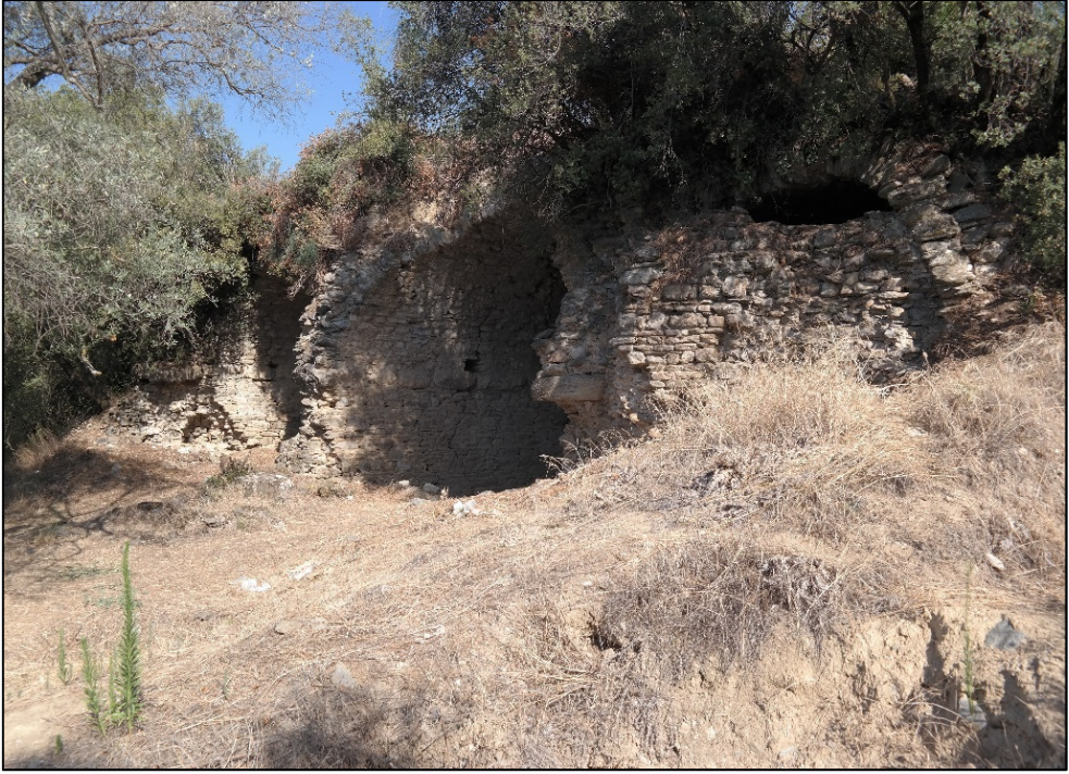
Resim 21. Güney Cephe, Toprak ve Moloz Dolgu Birikintileri.
