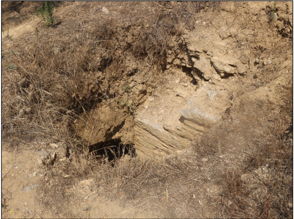
Resim 22. Güney Cephe, Toprak ve Moloz Dolgu Birikintileri
