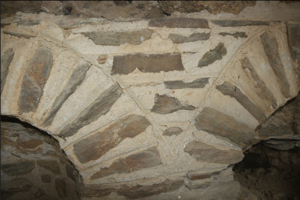
Resim 12. Güney Cephe Destek Duvarı Altındaki Tonozlu Alan Duvarlarında Kullanılan Harç Malzeme.
