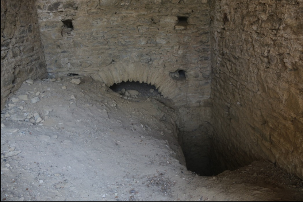
Resim 27. Güney Dış Cephe Tonozlu Mekanlarda Yapılmış Olan Kaçak Kazılar.
