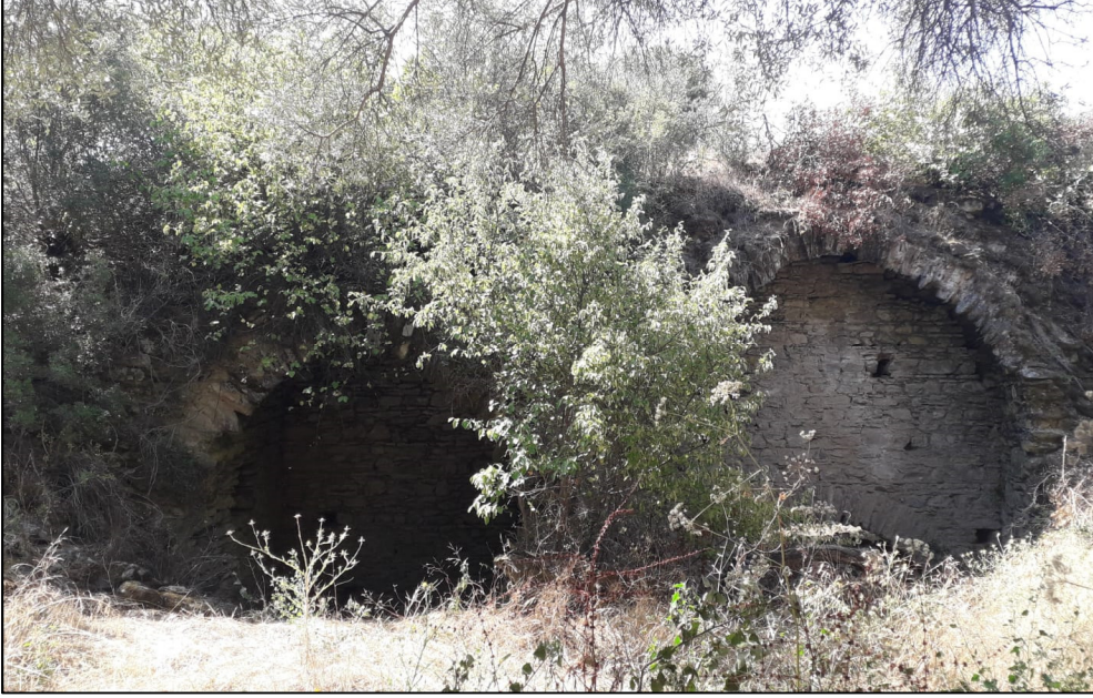
Resim 7. Güney Cephe İç Tonozlar.
