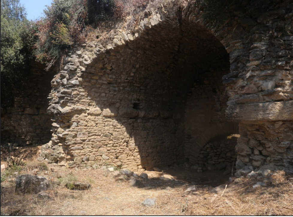
Resim 15. Güney Dış Cephe, Geniş ve Dar Örgü Alanlarında Görülen Birim Malzeme Kayıpları.
