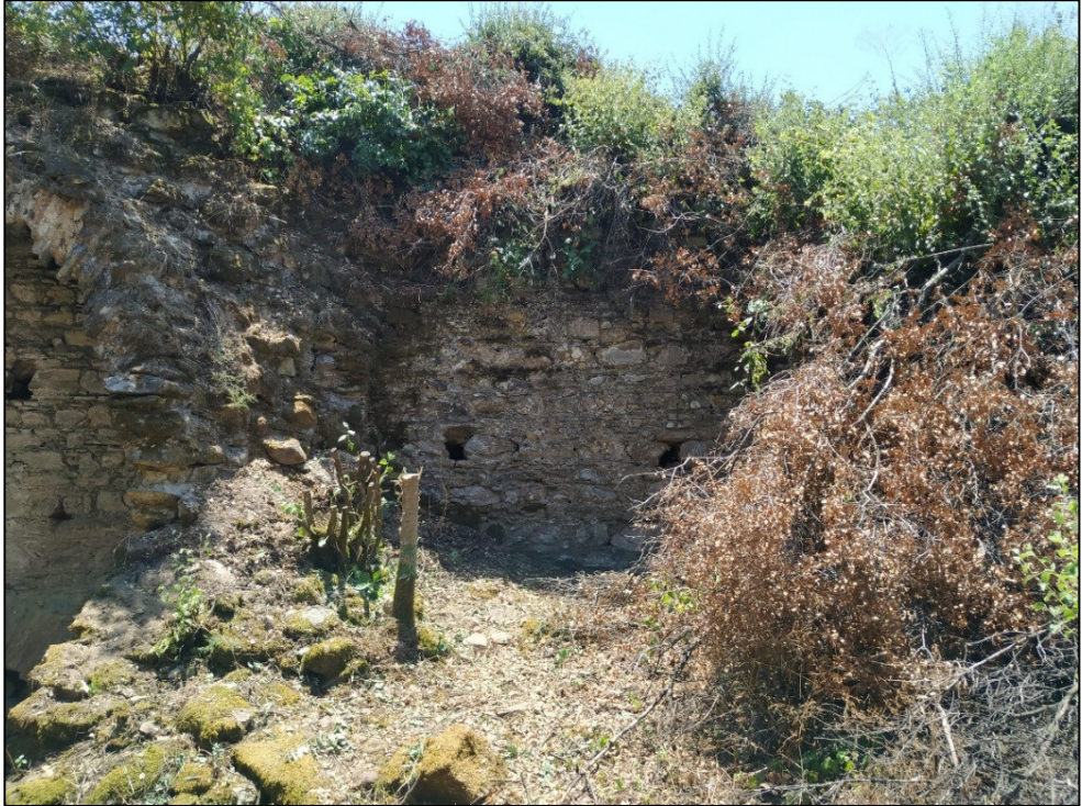
Resim 8. Güney Cephe İç Tonozlar.
