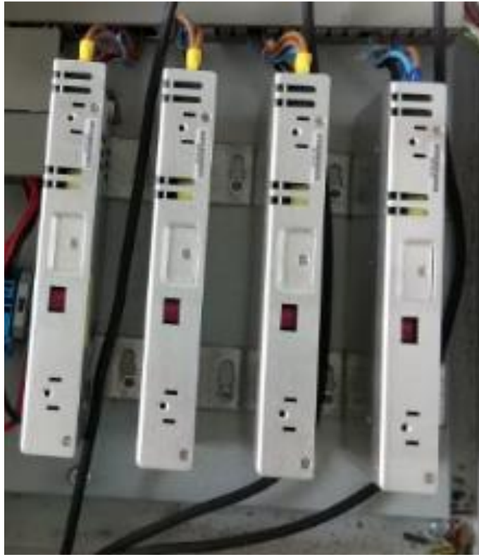
Şekil 3.33: Sürücü besleme trafoları
