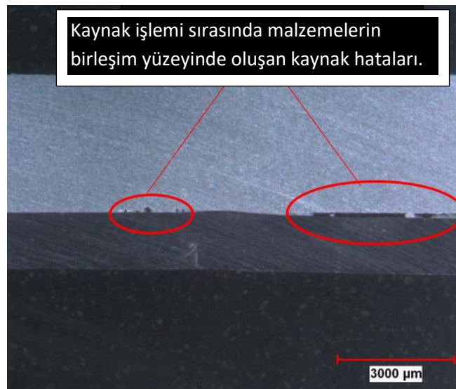
Şekil 7.7 Korozyon testi öncesi AISI 304 – AA5083 malzeme çiftinin 7,5X büyütmede çekilmiş makroyapı görüntüsü.
