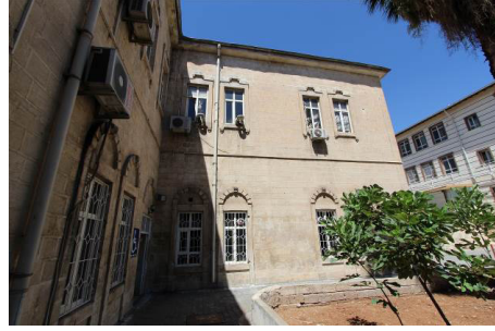
Fotoğraf 9: Şanlıurfa Hamidiye Hastanesi Batı Kanadının Doğu Cephesi
