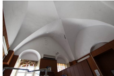
Fotoğraf 3: Şanlıurfa Hamidiye Hastanesi Zemin Kat Odalarının Örtü Sistemi
