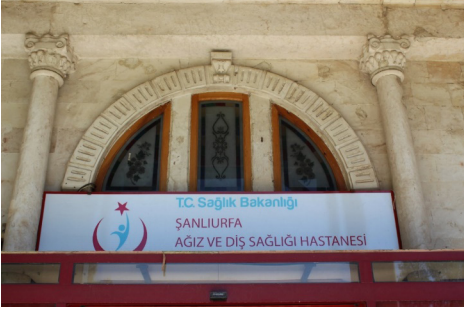
Fotoğraf 10: Şanlıurfa Hamidiye Hastanesi Ana Kapı Açıklığı Kemer ve Balkonları Destekleyen Sütunlar
