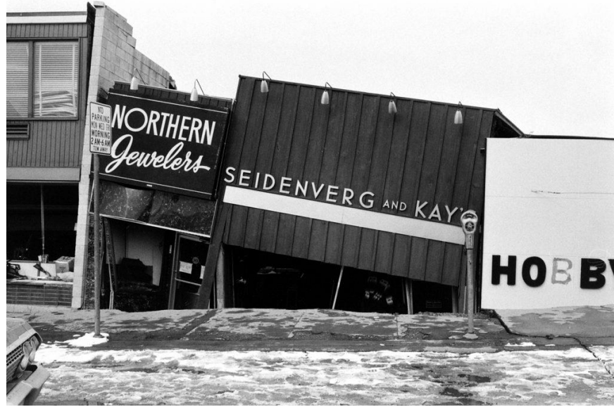
Şekil 3.1: 1964 Alaska depreminde meydana gelen sıvılaşma kaynaklı hasar (Ray, 1964).
