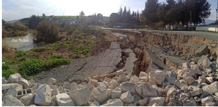
Şekil 3.6: 2023 Hatay Depremi nedeniyle Asi Nehri'nde gelişen yanal yayılma hasarı (MTA, 2023).
