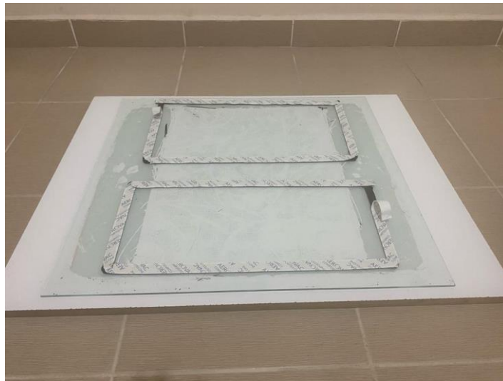
Şekil 3.13: Sızdırmazlık bandının yapıştırılması
