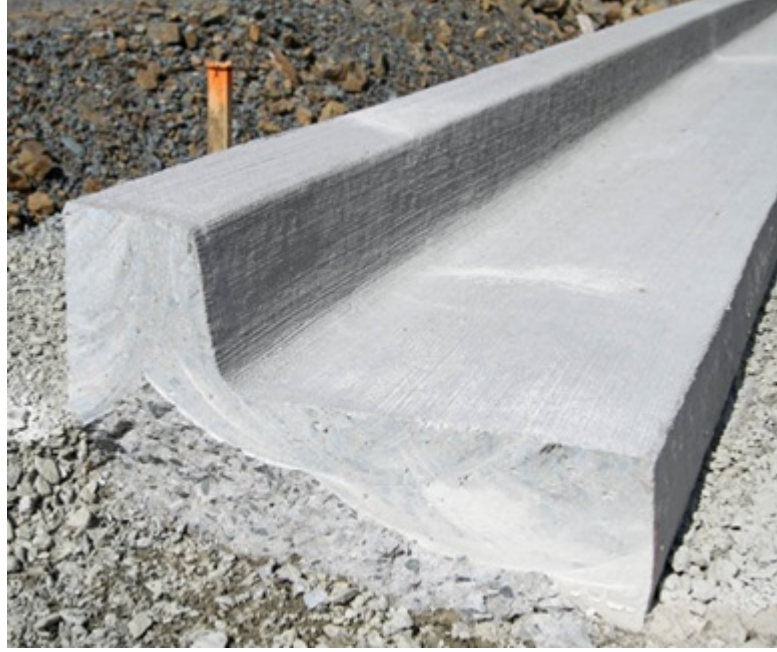
Şekil 3.1: Beton bordür (URL 9)
