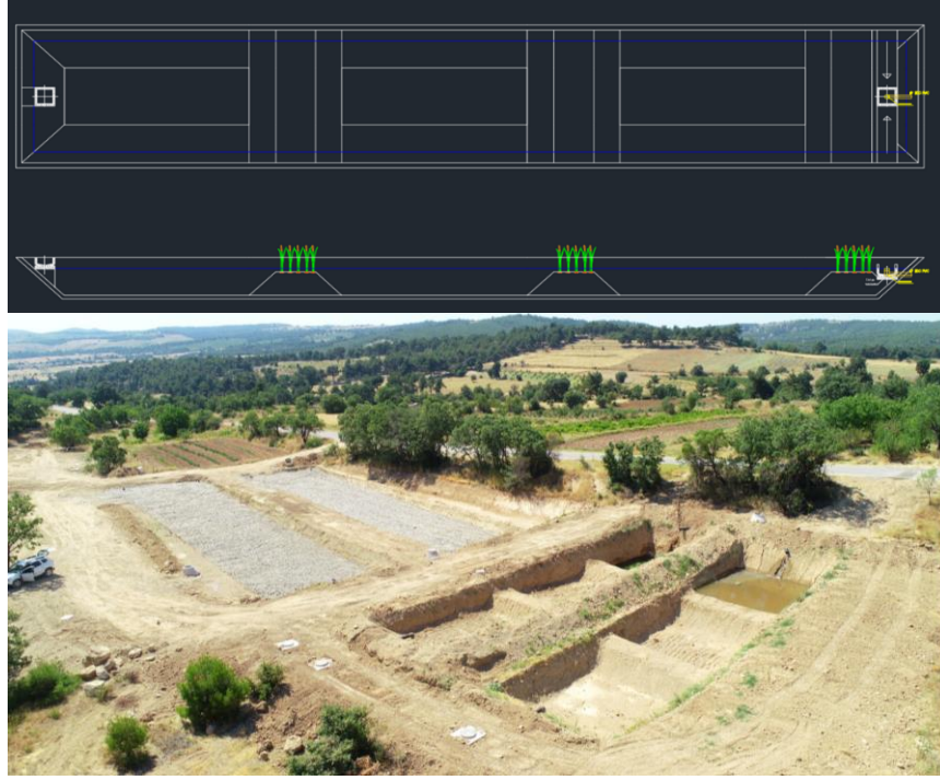
Şekil 6.23: Yeni tasarlanıp uygulanan ön çöktürme hazneleri
