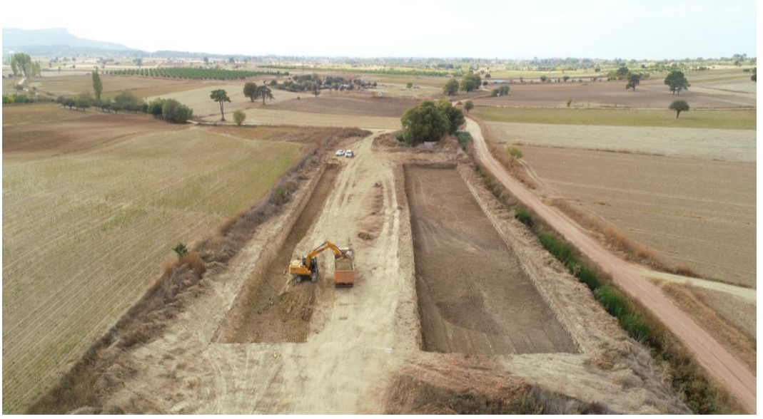
Şekil 6.41: Kale Karaköy YSA tesis kazısı
