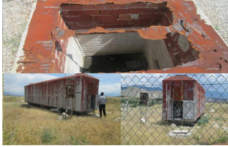
Şekil 5.1: Atıl durumda kalmış bir paket biyolojik arıtma tesisinin görüntüsü (DESKİ, 2014)
