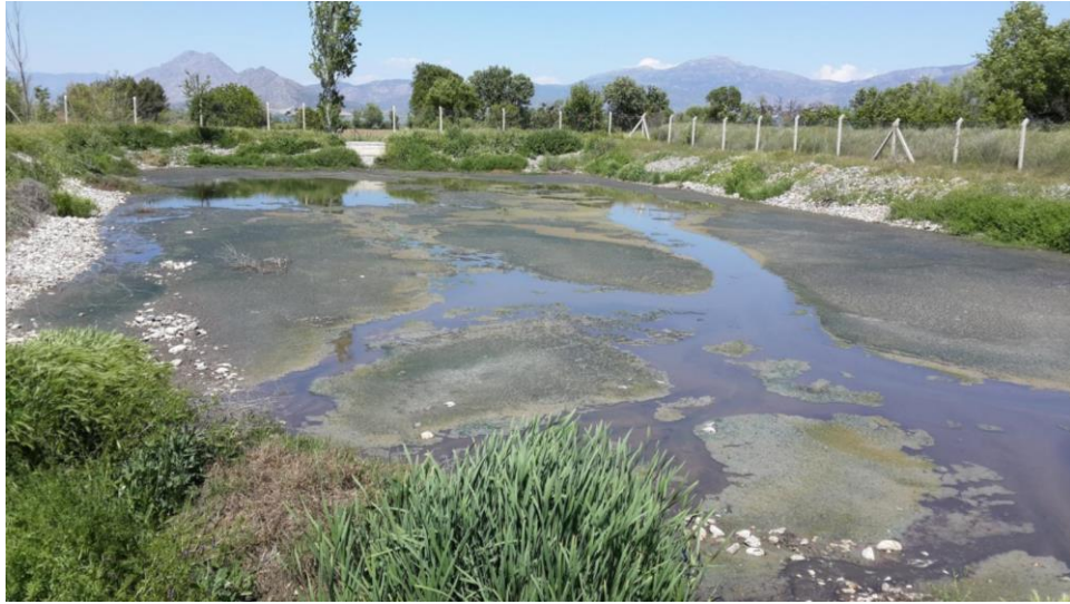
Şekil 5.24: Darıveren 1 YSA'da yatakta tıkanma, yüzeyel akış başlangıcı, bitki oluşmaması
