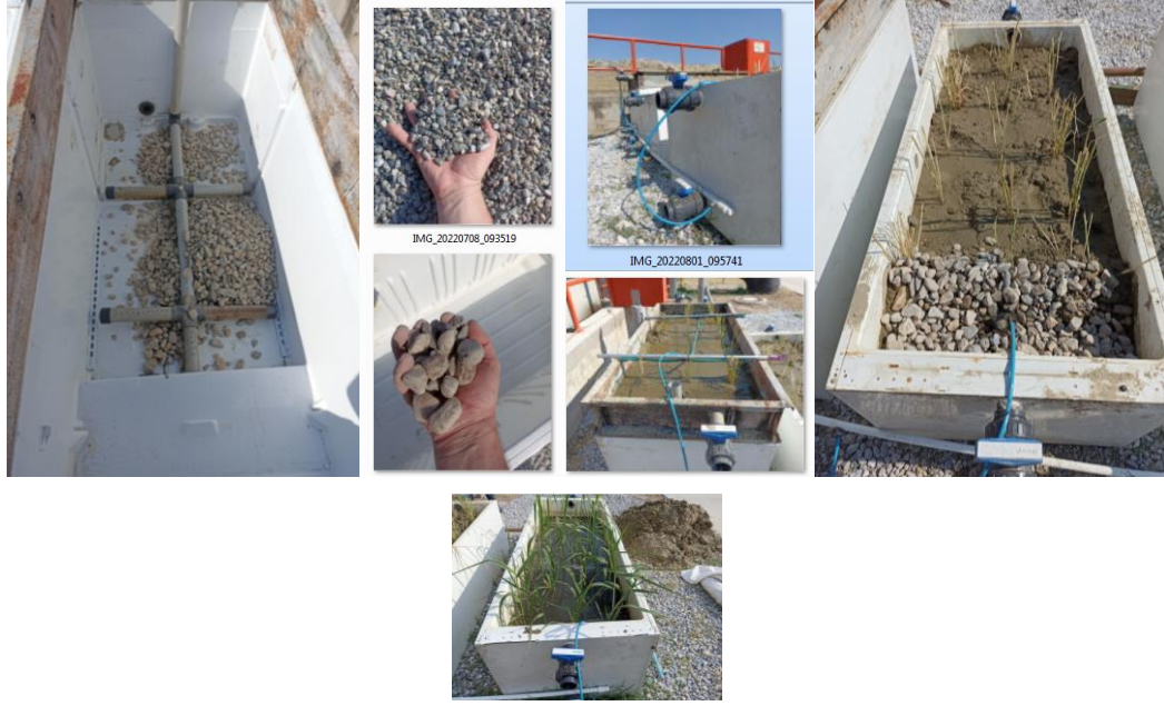
Şekil 5.12: Pilot havuzlar ve yatak malzemesi serilmesi, bitkilendirme gibi basamakların resimleri
