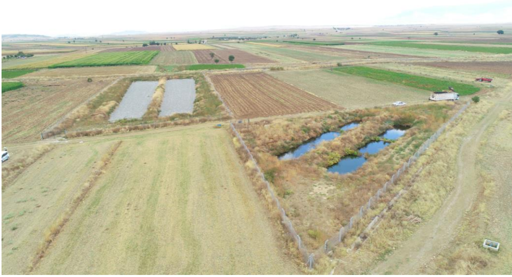
Şekil 6.27: Çardak Beylerli tesisinde serbest yüzeyli havuzların dolumu
