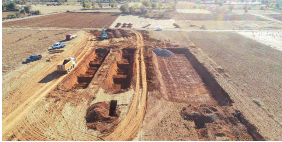
Şekil 6.38: Tavas Derinkuyu yüzeyaltı yatay akışlı YSA ve serbest yüzeyli ön çöktürme hazneleri
