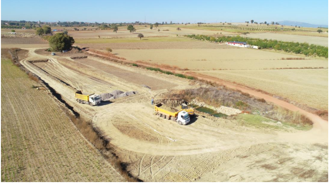
Şekil 6.42: Baklan Dağal Doğal Arıtma Tesisi çakıl serimi
