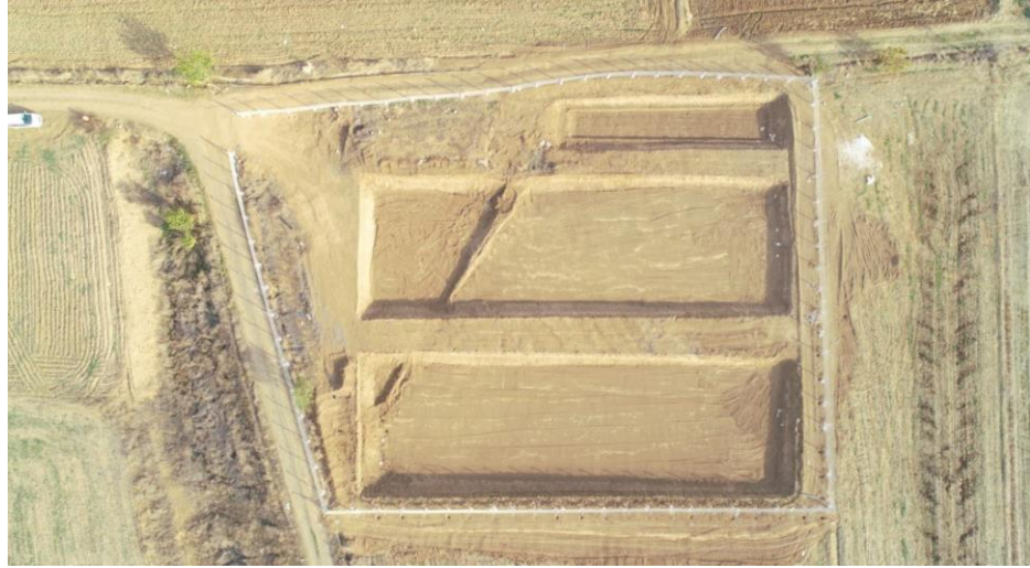
Şekil 6.39: Acıpayam Gümüş Doğal Arıtma tesisi kazısı
