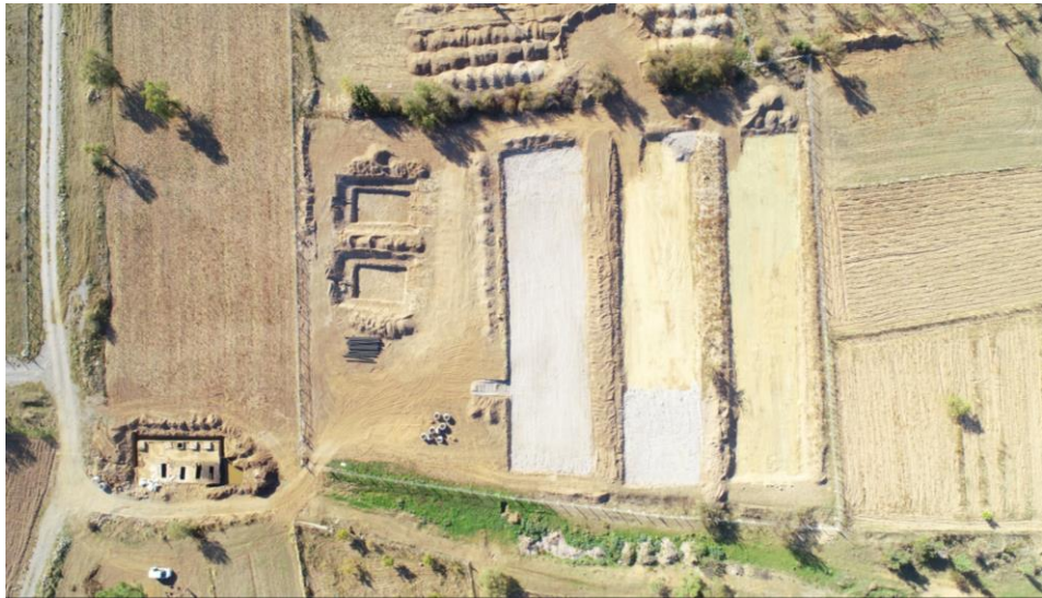
Şekil 6.36: Tavas Balkıca Doğal Arıtma çakıl serimi havadan görünüm
