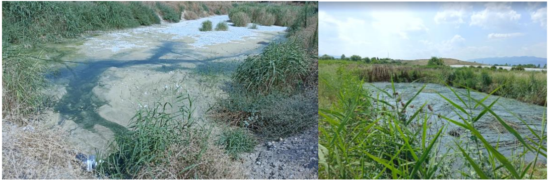
Şekil 6.29: Sarayköy Duacılı’da dikilen sazlarla ilgili ilk gelişimler ve mavi renkli endüstriyel atıksu girişi ile çakıl yatakta yüzeysel akış
