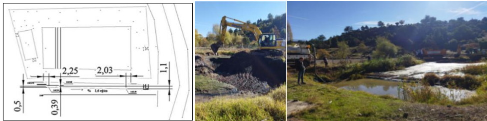
Şekil 6.22: Önceki tesislerde deneme amaçlı oluşturulan ve uygulanan çökeltim lagünü
