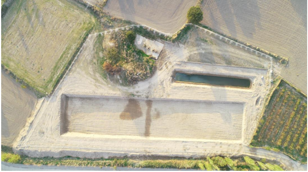
Şekil 6.45: Civril Kocayaka YSA, paralel ön çöktürme haznesi
