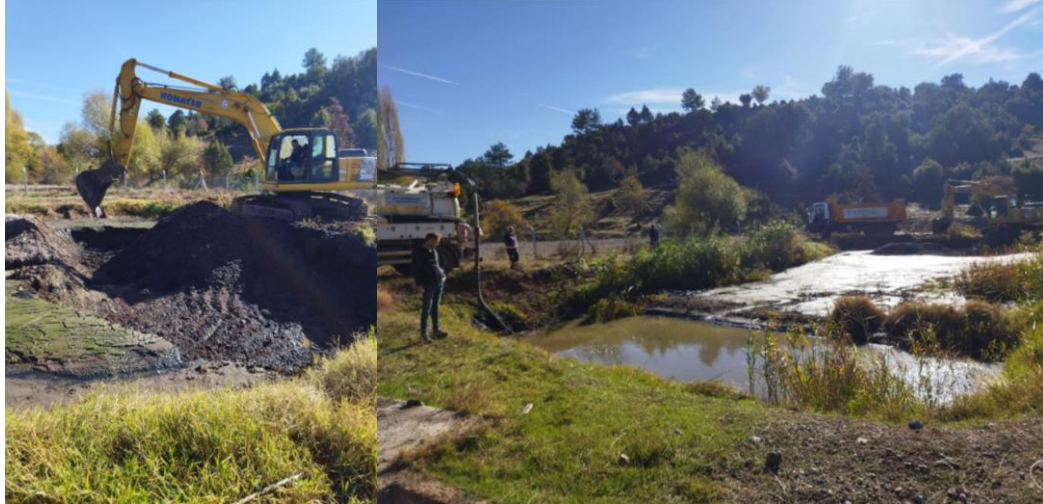
Şekil 5.17: İlerleyen dönemde ön çöktürme haznesi temizliği
