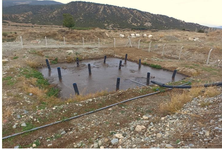
Şekil 6.37: Bozkurt İnceler’de ilk kez denenen aktif çamur kurutma sazlığı
