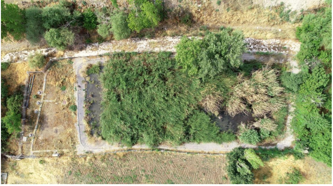
Şekil 5.4: Denizli Alikurt Doğal Arıtma Tesisi havadan görünüm (2021)
