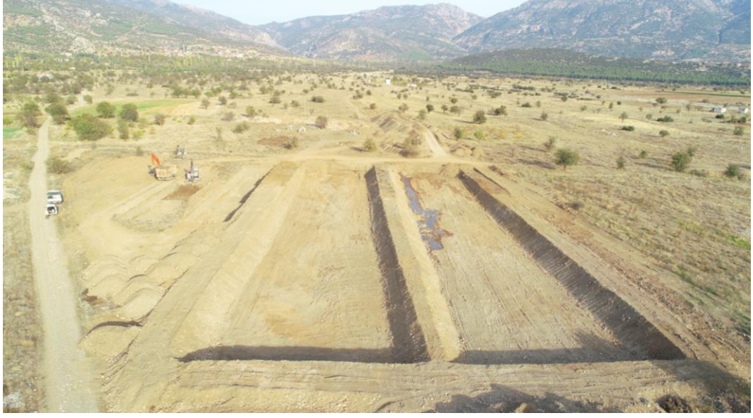
Şekil 6.43: Acıpayam İlçesi Dodurga Doğal Arıtma kazı çalışmaları
