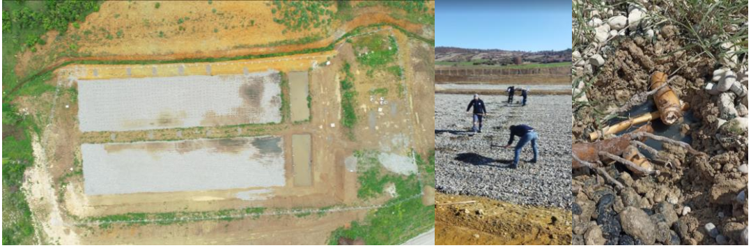
Şekil 6.25: Çardak Söğüt Doğal Arıtma Tesisi kazı çalışmaları
