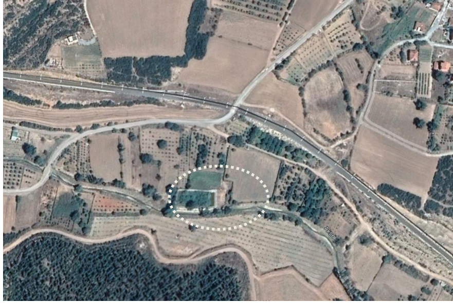
Şekil 5.3: Alikurt Doğal Arıtma Tesisi uydu görüntüsü
