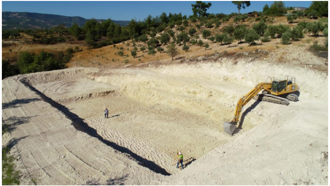
Şekil 6.46: Güney Ertuğrul YSA eğimli arazide kazı çalışmaları
