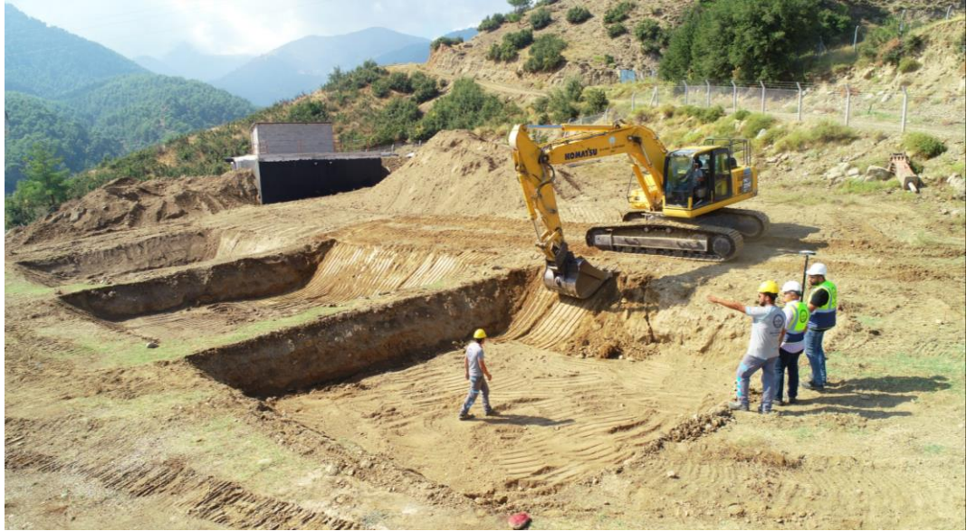
Şekil 6.40: Babadağ Kelleci betonarme AKR çamur kurutma yatakları
