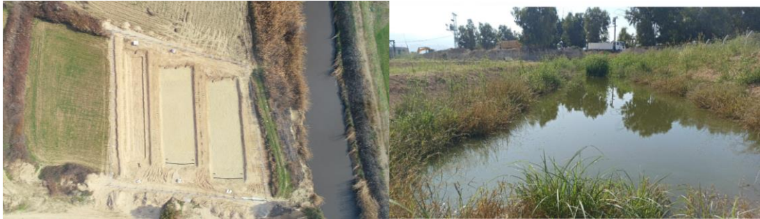
Şekil 6.34: Sarayköy Karataş'ta Büyük Menderes Nehri kolu kenarında YSA yüzeyaltı yatay akışlı haznelerin üstten görünüşü ve serbest yüzeyle ön çöktürme havuzu
