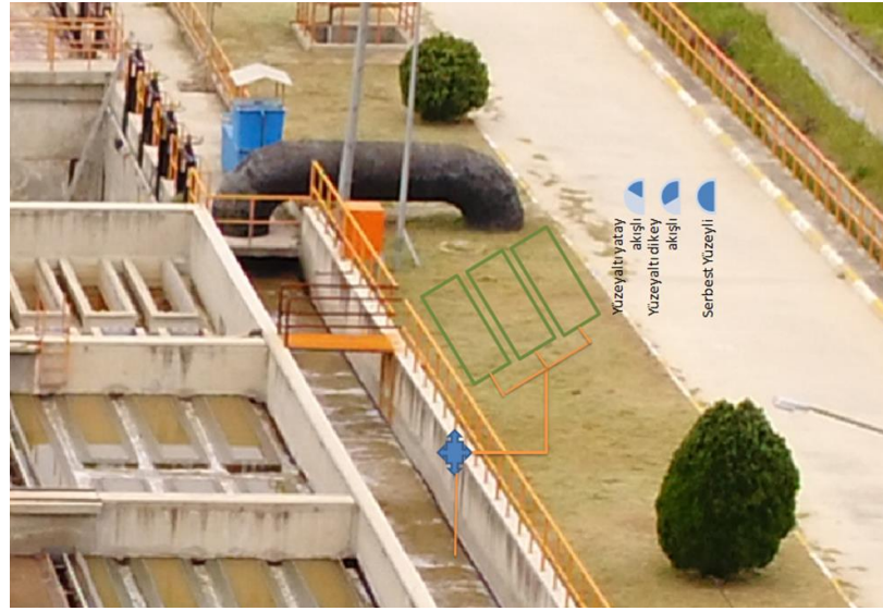
Şekil 5.9: Denizli Merkez AAT içerisinde yeni pilot sulak alanlarının kurulduğu alan
