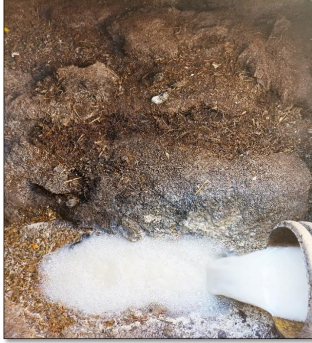
Şekil 5.14: Evsel atıksu arıtımı amaçlı yapılan Pınarlık YSA'na gelen hayvan gübresi ve mandıra kaynaklı atıksu girişi (Akyürek 2024)
