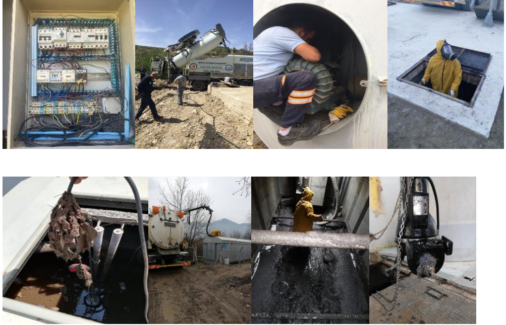
Şekil 5.2: Denizli'deki paket biyolojik arıtma tesislerine ait bakım ve temizlik işlemlerinden görüntüler
