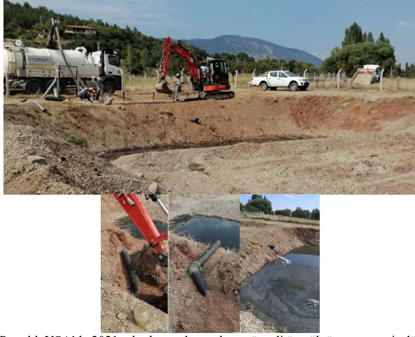
Şekil 5.16: Pınarlık YSA'da 2021 yılında yapılan serbest yüzeyle ön çöktürme ve geçiş düzenlemeleri
