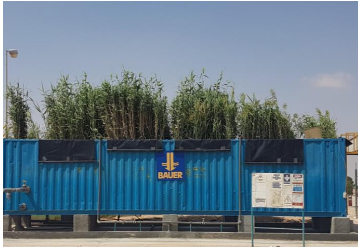
Şekil 4.3: Yenilikçi paket doğal arıtma tesisi (Stefenakis 2019)
