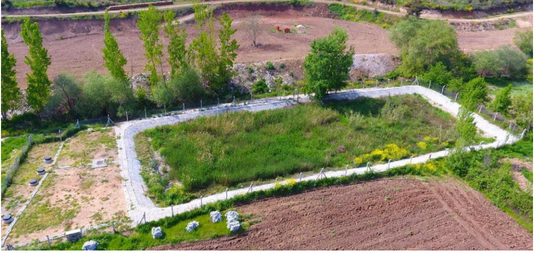
Şekil 5.18: Alikurt Doğal Arıtma Tesisinde 2018 yılı bitkilerde ilk gelişimler
