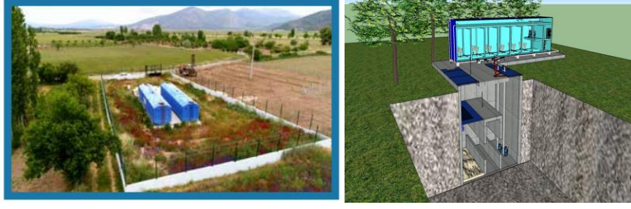
Şekil 5.5: Denizli Tavas Garipköy Paket Atıksu Arıtma Tesisi resmi ve kesit görüntüsü
