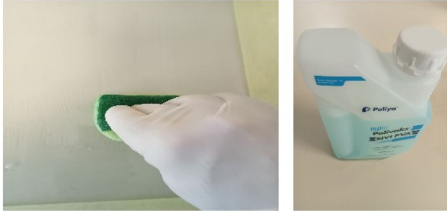
Şekil 6.3: Polivaks sıvının cam'a uygulanması
