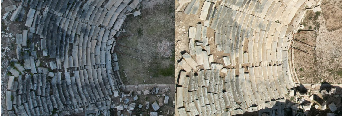
Figür 51. Tiyatro yapısı Orchestra bölgesinde yer alan Orthostat ve Parapet bloklarının yıkılması.
