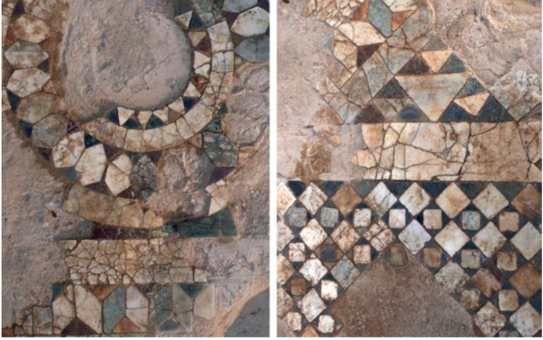
Fig. 39: Philippus Kilisesi narteks bölümü opus sectile döşeme detayları.
