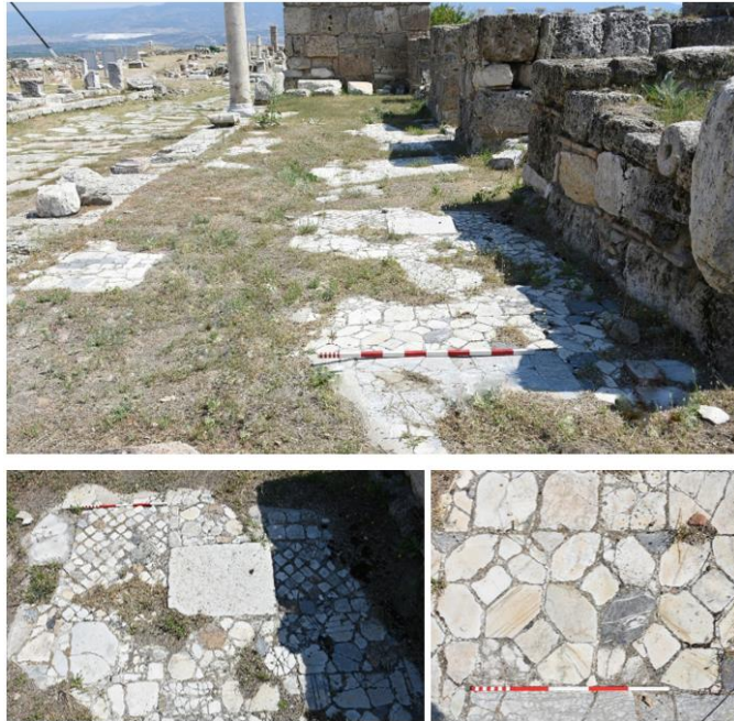
Fig. 95: Stadyum Caddesi dođu portikte yer alan mekânların önlerindeki opus sectile döşemeler ve detayları.
