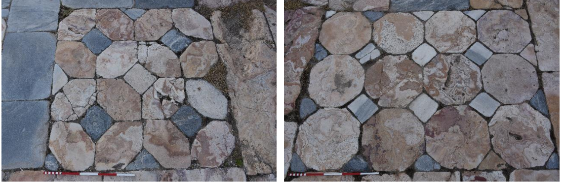
Fig. 111: Tripolis Agorası batı portik M4 ve M7 motifli opus sectile döşeme detayları.
