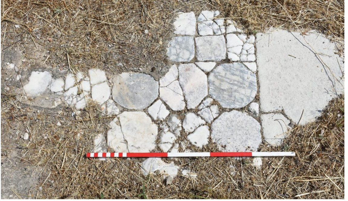
Fig. 106: Suriye Caddesi kuzey portik mekân önündeki opus sectile döşemeden detay.
