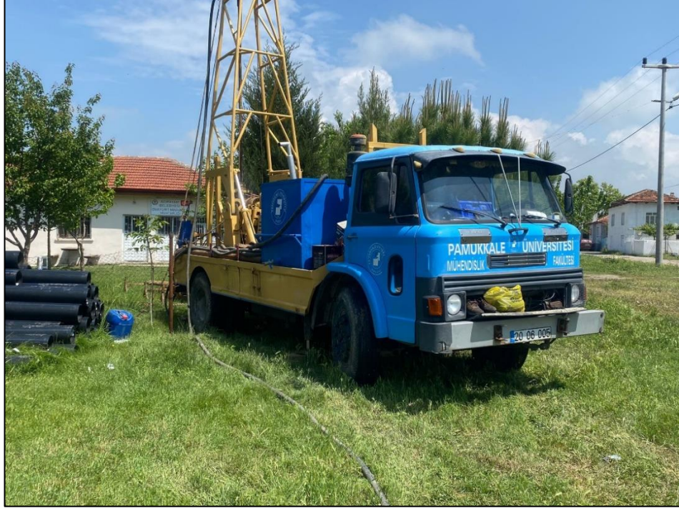
Şekil 2.1: Arazideki sondaj çalışmalarından görünüm
