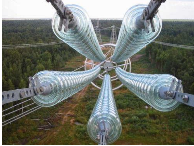
Şekil 3.4: Zincir tipi cam malzemeden izolatör.
