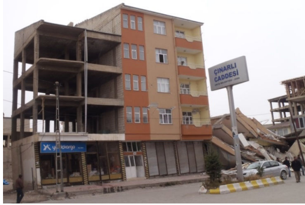
Şekil 1.3: 23 Ekim 2011 Erciş Depremi Sonrası İki binanın Ekseninden Kaydığı Ve Sağdaki Binanın Yıkıldığı Komşu Üç Bina (Ozmen ve diğ., 2013)
