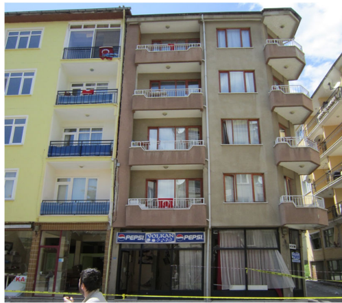
Şekil 1.4: 19 Mayıs 2011 Simav Depremi Sonrası 8 Komşu Binanın En Sağında Yer Alan Binanın Ekseninden Kalıcı Olarak Kayması (Ozmen ve diğ., 2013)
