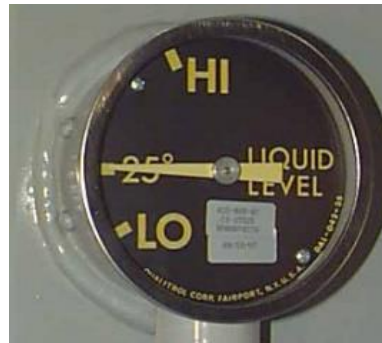
Şekil 2.14: Yağ seviye göstergesi.
