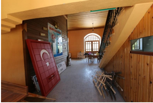
Foto 7: Zemin Kat Güney Giriş Holü (Öz Çekim 16.08.2022)
