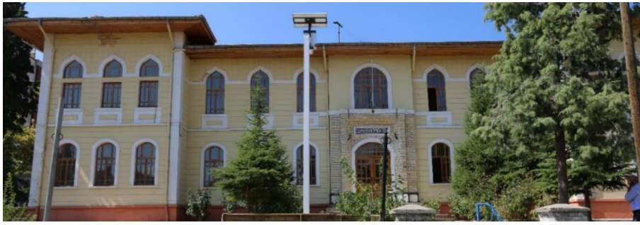
Foto 23: Kuzey Cephe (Öz Çekim 16.08.2022)
