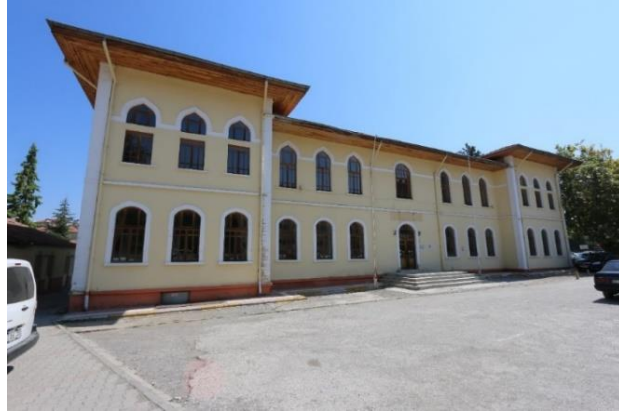
Foto 24: Güney Cephe (Öz çekim 16.08.2022)
