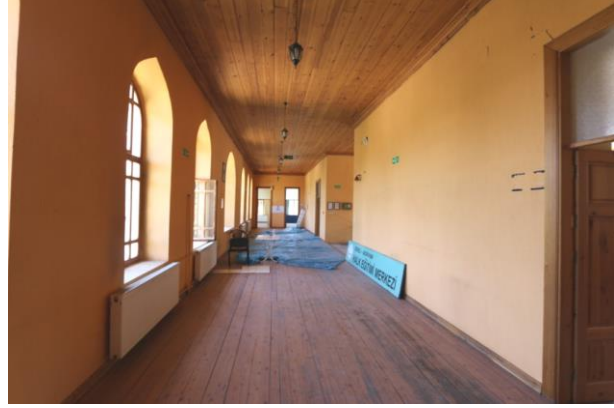
Foto 16: Birinci Kat Koridoru Güneydoğu Yönü (Öz Çekim 16.08.2022)
