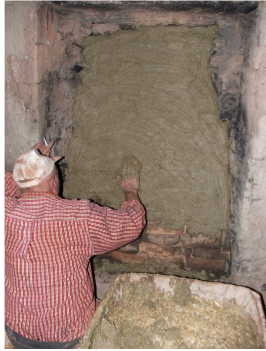
Fotoğraf 46-47: Fırının Doldurma Boşaltma Ağızının Tuğla İle Örülmesi ve Çamurla Sıvanması
