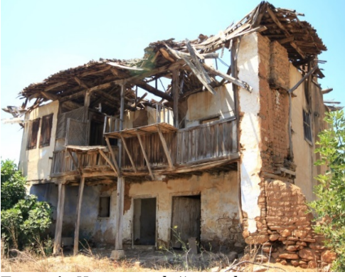
Foto. 1. Kuzey ve doğu cephe
