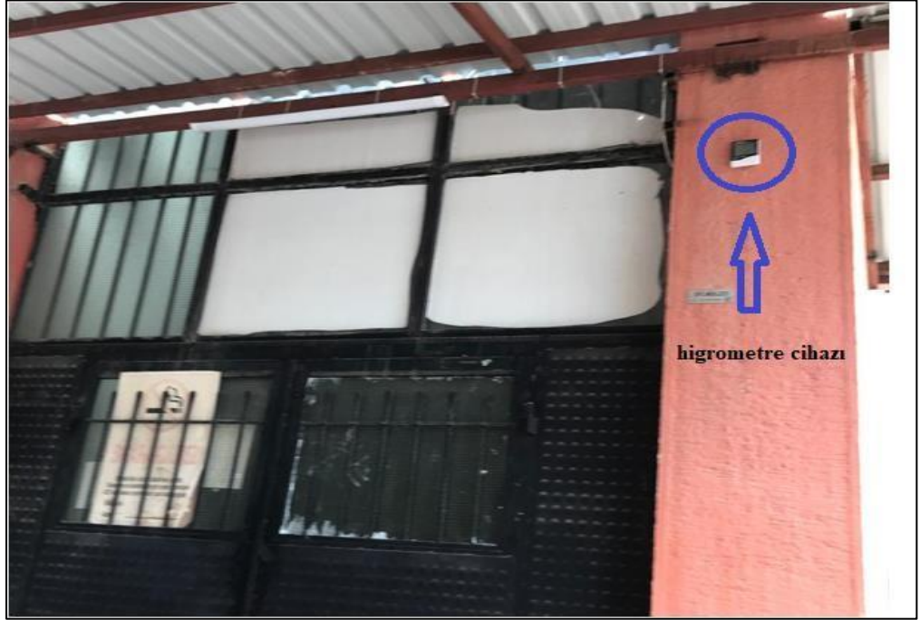
Şekil 4.2: Kapalı spor salonunun giriş kapısı ve dış duvara asılı higrometre.
