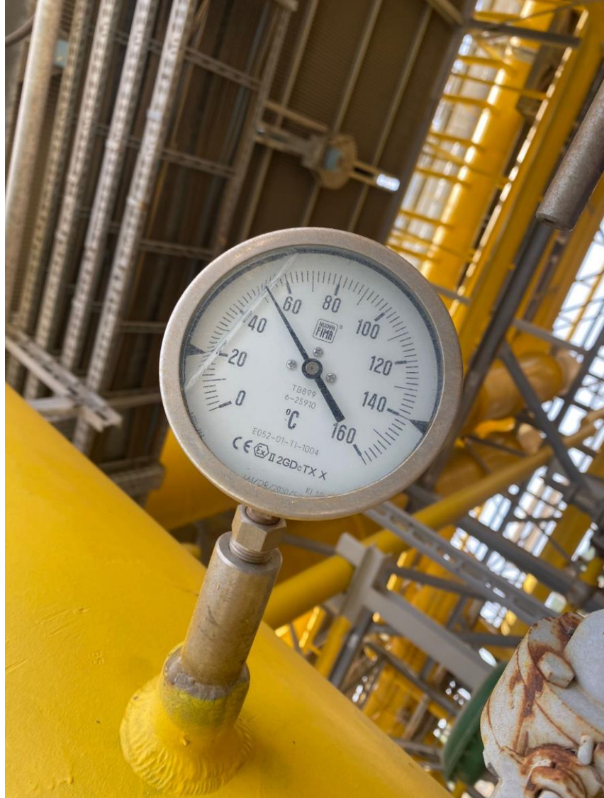
Őekil 4 6: ORÇ Pompa basma hattı sıcaklık göstergesi
